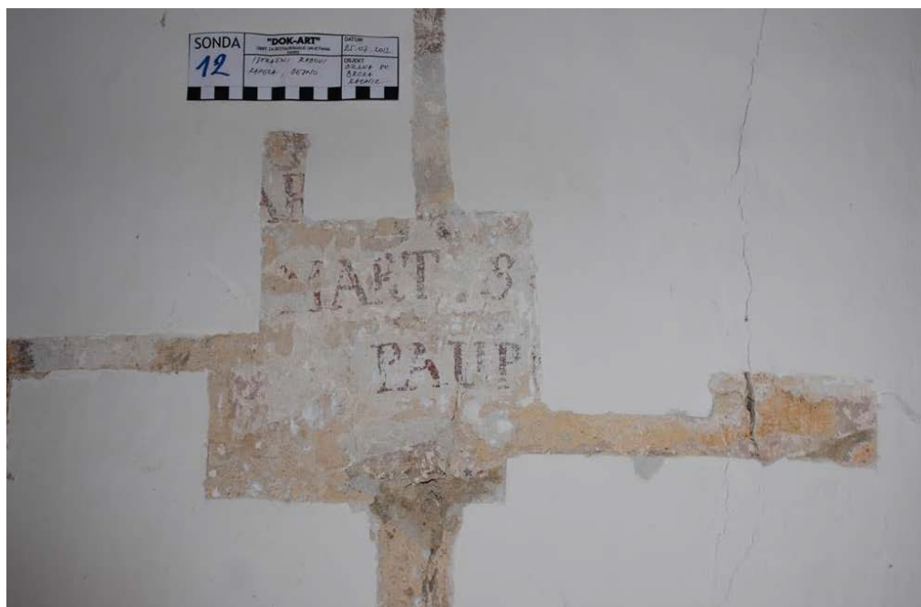
Slika 46: Sonda na zapadnom zidu ulaza u kapelu
