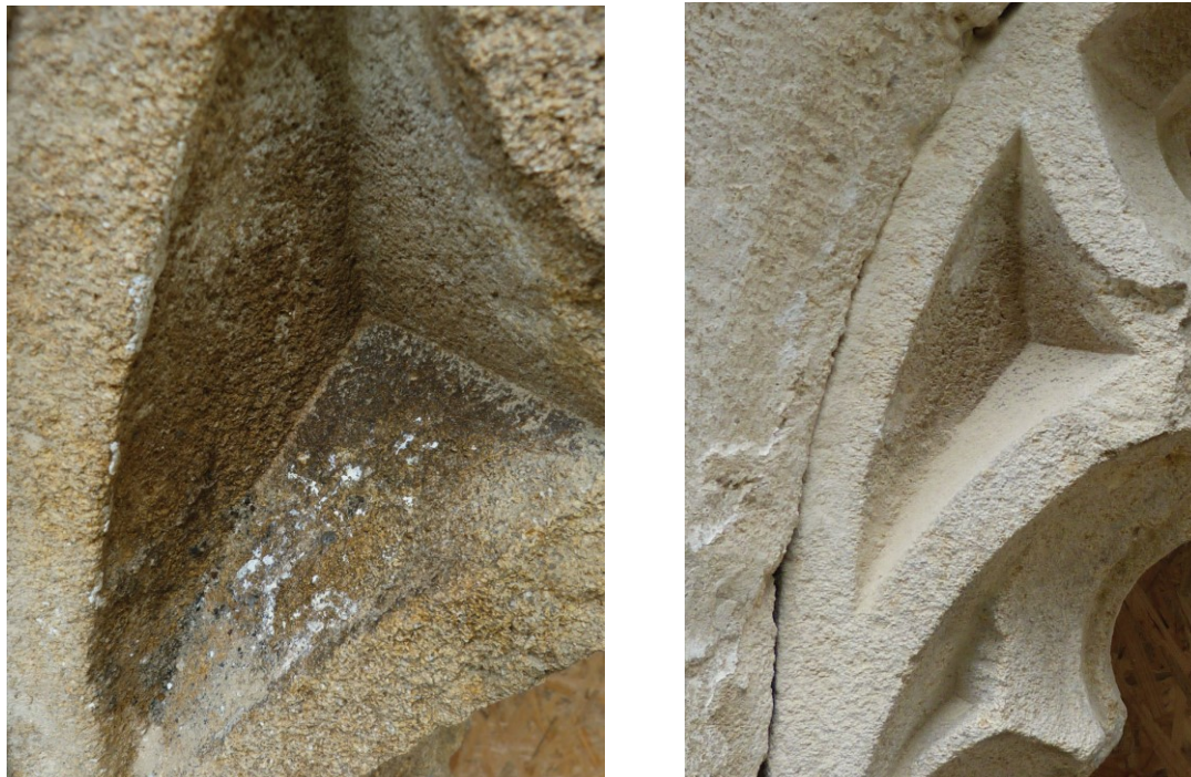
Slika 66 i 67: južni prozor svetišta, mrežište, prije i poslije dodatnog čišćenja 2015. godine
