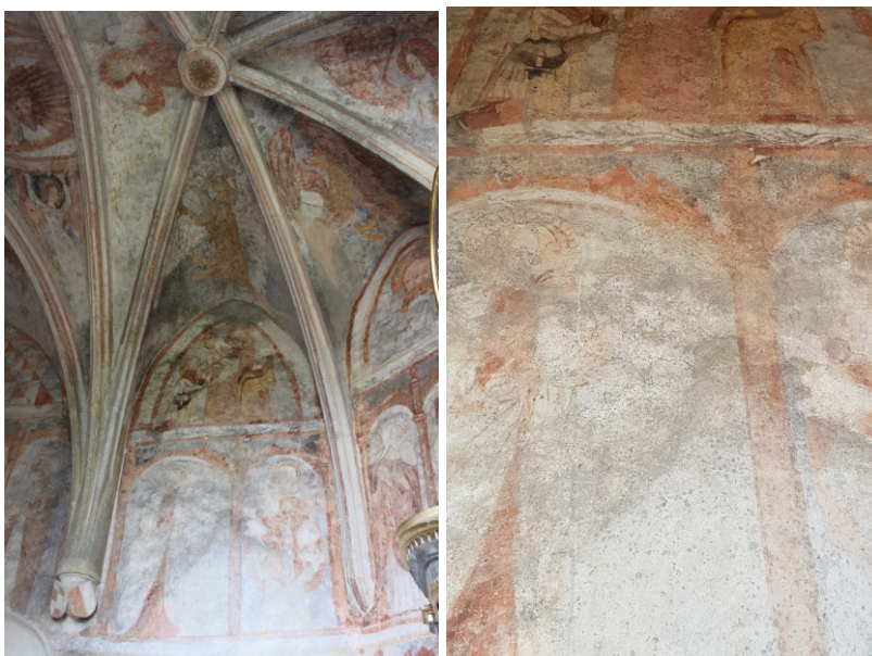
Slika 69 i 70: pogled na sjeverni zid i dio stropa
