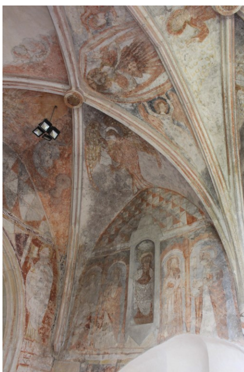
Slika 71: pogled na sjeverni zid i sjeverozapadni dio stropa
