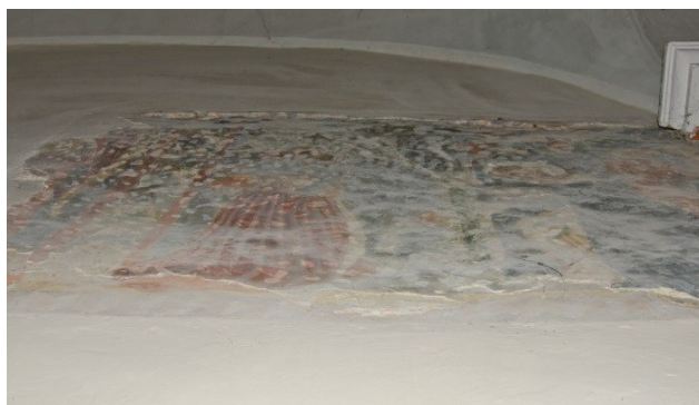
Slika 34: Različita visina naknadne žbuke u odnosu na izvornik
