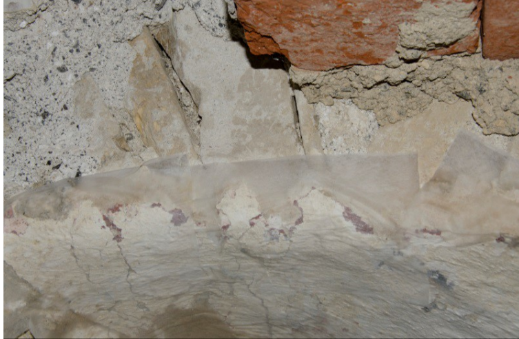
Slika 51: Luk prozorske niše tijekom opšivanja rubova izvorne žbuke i konsolidacije oslika preko japanskog papira
