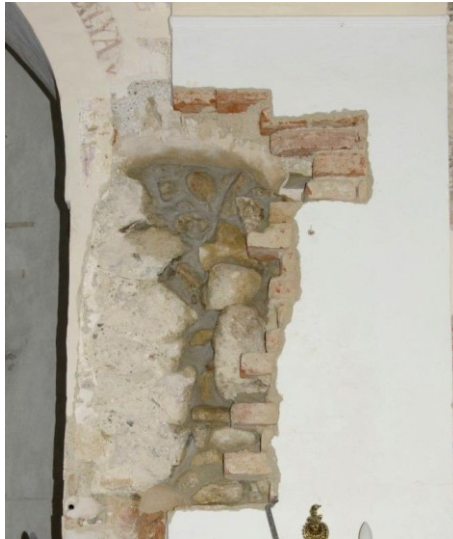
Slika 52: Niša nakon zapune novom građom
