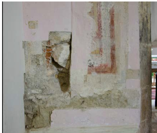
Slika 37: Sonda u donjem lijevom dijelu trijumfalnog luka sa strane lađe
