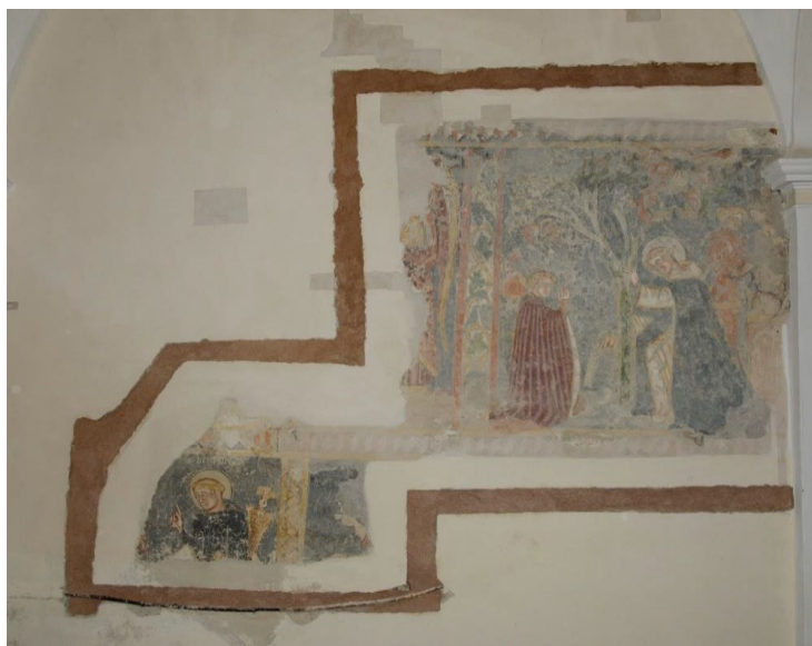
Slika 55: Ispuna utora oko oslika žrtvovanom žbukom
