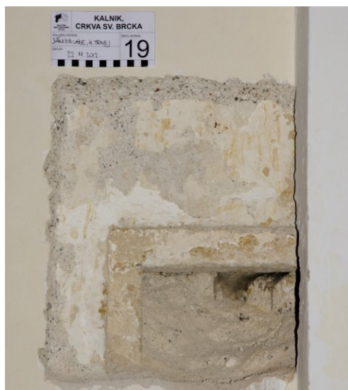
Slika 36: Stratigrafska sonda 19
