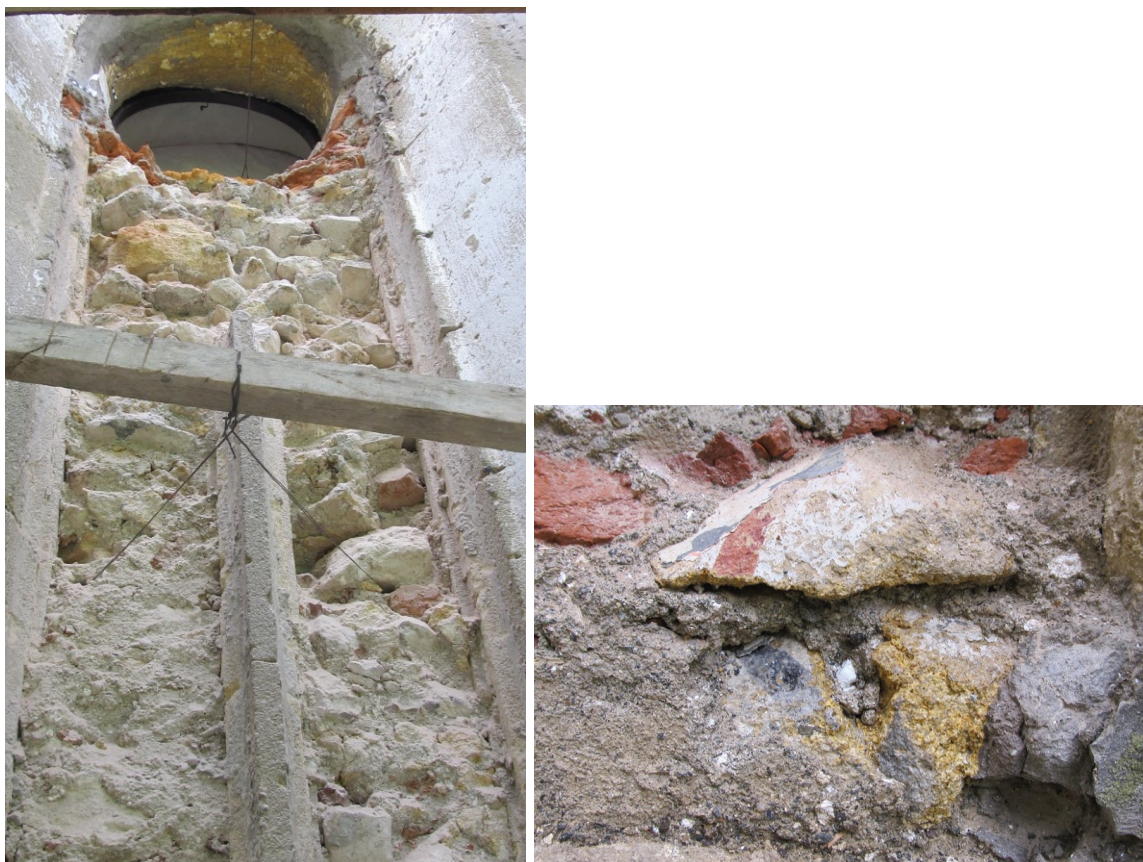
Slika 64: središnji prozor svetišta nakon uklanjanja površinskog sloja cementne žbuke 2015. godine
