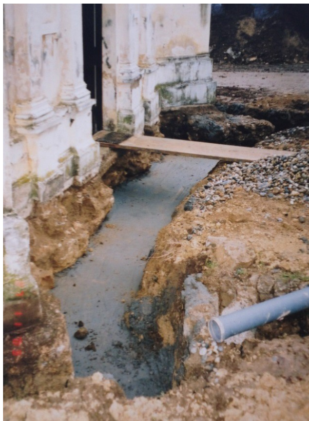
Slika 15: Zapunjavanje jarka oko crkve betonom, snimljeno u studenom 2003. godine
