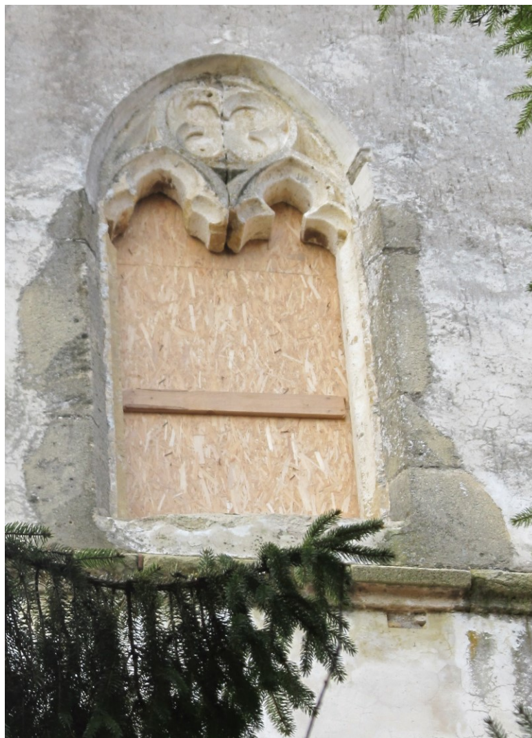
Slika 68: istočni prozor treće etaže zvonika nakon završenih radova u prosincu 2015. godine
