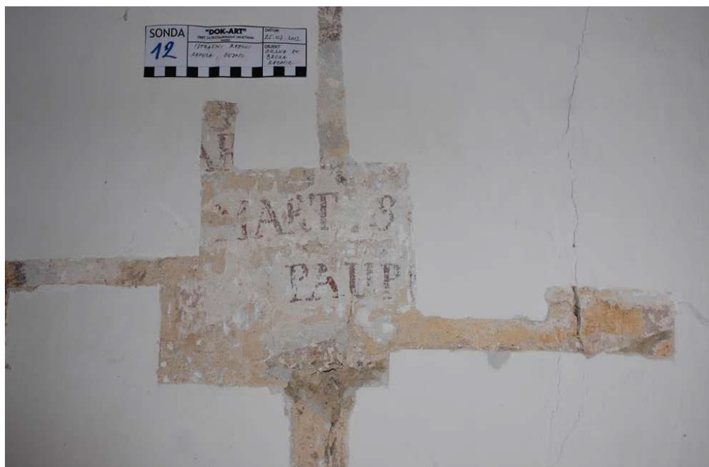
Slika 46: Sonda na zapadnom zidu ulaza u kapelu
