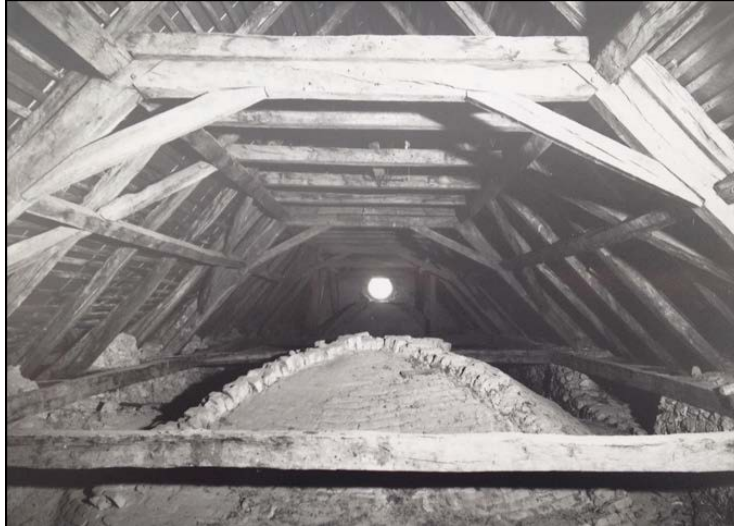
Slika 16: Krovšte crkve – pogled prema zapadu na konstrukciju svodova lađe prije početka radova, 1993. godine
