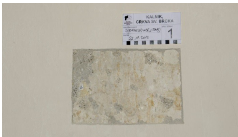
Slika 32: Sonda 1, primjer sonde u gornjoj zoni sjevernog zida u drugom traveju
