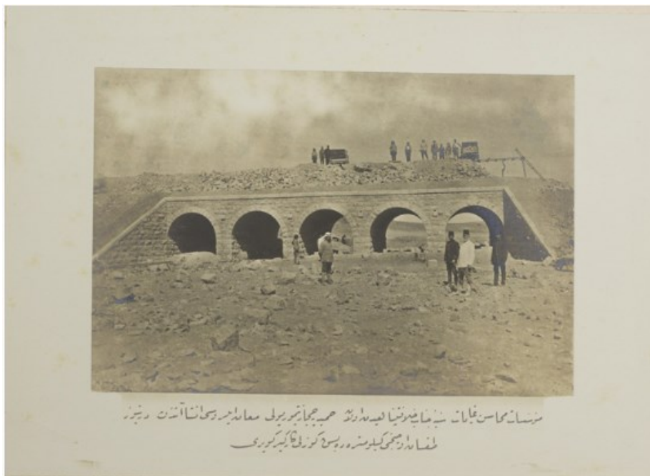
Slika 28: Izgradnja željezničke pruge Hijaz
