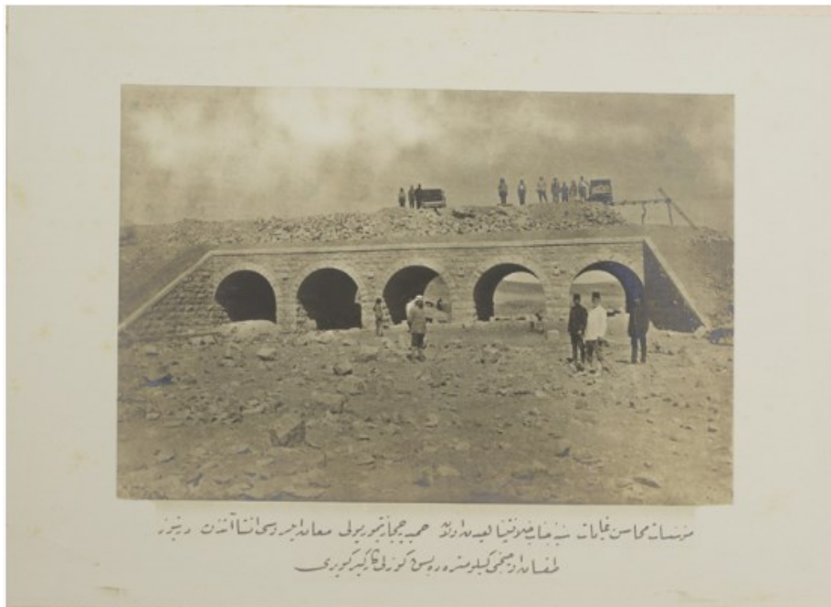
Slika 28: Izgradnja željezničke pruge Hijaz
