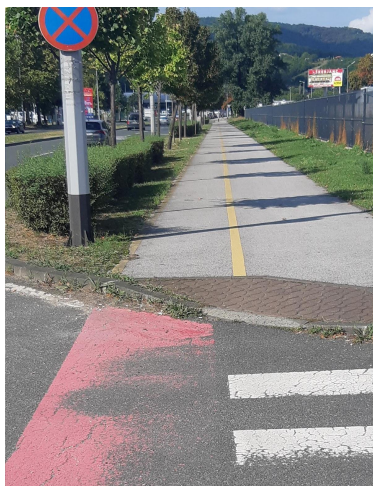
Slike 22. i 23. Nepravilno izvedeno spuštanje rubnjaka, prepreka na stazi, neodržavanje staze - Škorpikova ulica, kolovoz 2022. (Autor: Mihovil Saganić Novaković)
