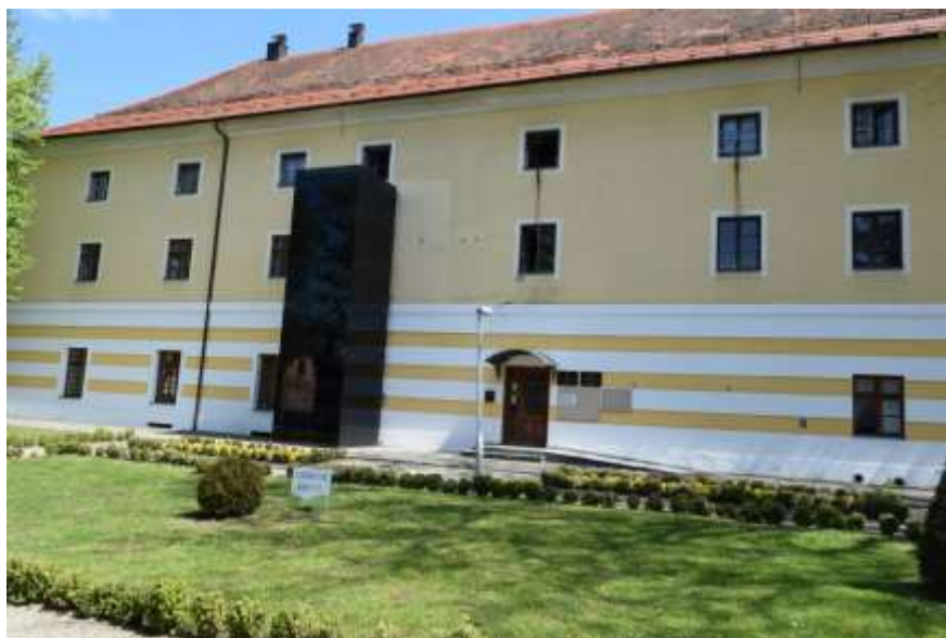
Slika 47. Zapadna bočna zgrada sklopa dvorca Batthyány, pogled na zapadno pročelje zgrade, ugrađeno vanjsko dizalo
