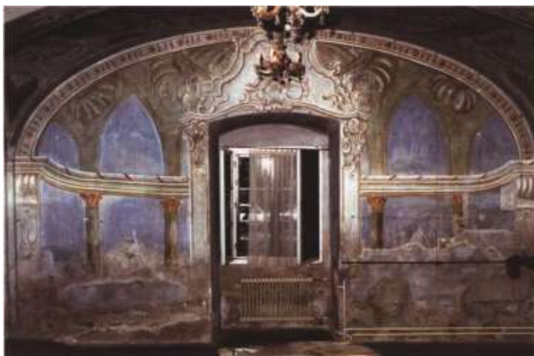
Slika 49. Zapadna bočna zgrada sklopa dvorca Batthyány, pogled na istočni zid velike dvorane prije radova
