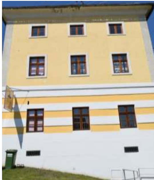
Slika 46. Istočna bočna zgrada sklopa dvorca Batthyány, pogled na južno pročelje zgrade
