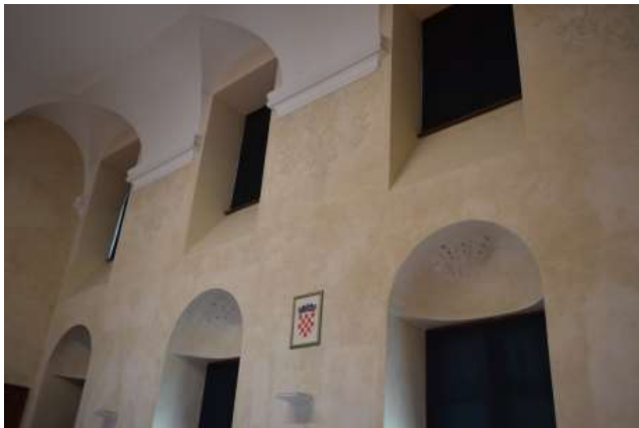
Slika 66. Glavna zgrada, dvorac Batthyány, pogled na zapadni zid „Velike dvorane“ na prvom katu zapadnog krila zgrade
