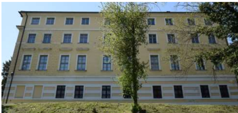
Slika 25. Glavna zgrada, dvorac Batthyány, pogled na pročelje istočnog krila zgrade
