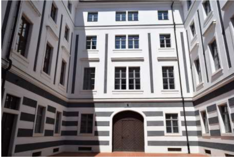
Slika 26. Glavna zgrada, dvorac Batthyány, pogled iz južnog krila prema sjevernom i dijelovima istočnog i zapadnog pročelja unutrašnjeg dvorišta
