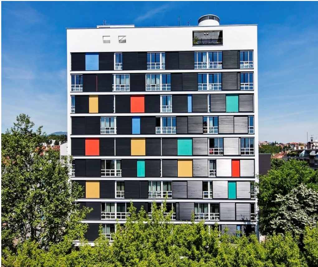
Slika 12. Južno pročelje nebodera (2017.)
