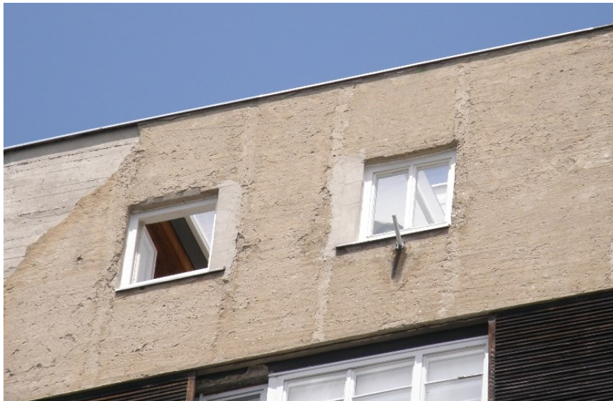
Slika 8. Detalj južnog pročelja i nelegalno ugrađeni prozori na prohodnoj terasi X. kata (2010.)
