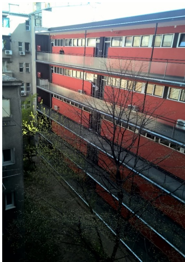
Slika 11. Pogled na galerije četverokatnice nakon radova
