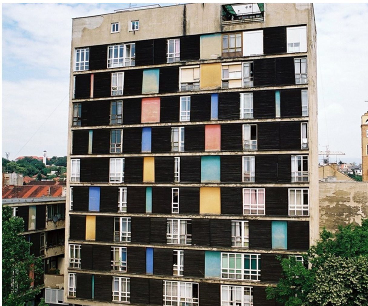
Slika 5. Vitićev sklop prije sanacije i obnove
