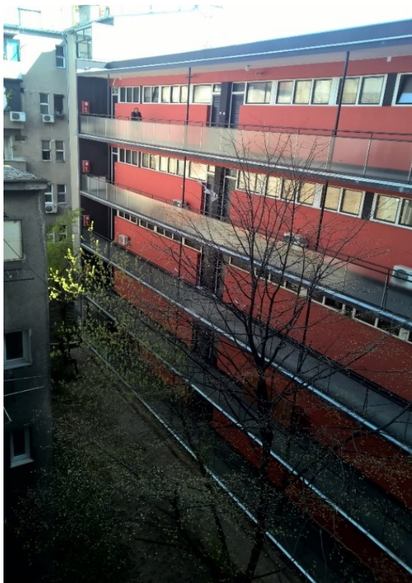
Slika 11. Pogled na galerije četverokatnice nakon radova
