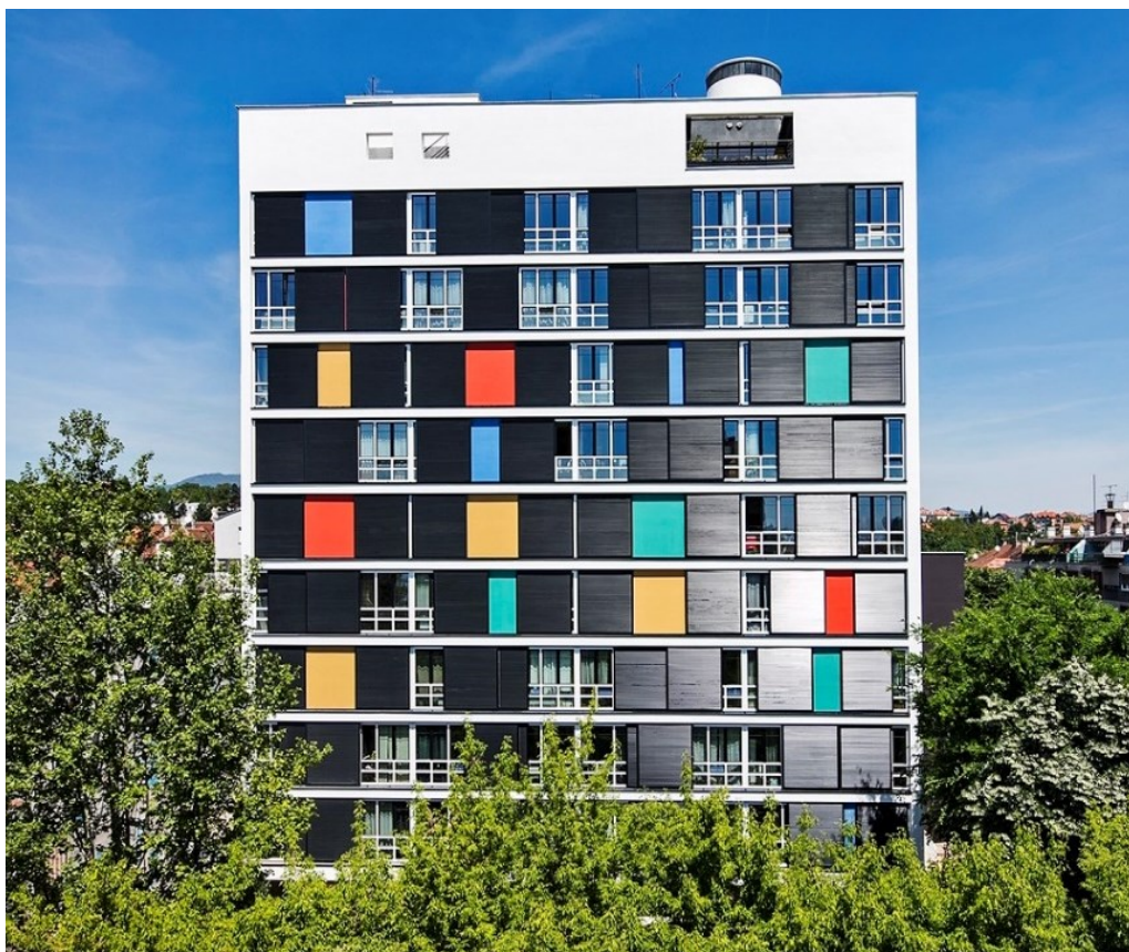
Slika 12. Južno pročelje nebodera (2017.)
