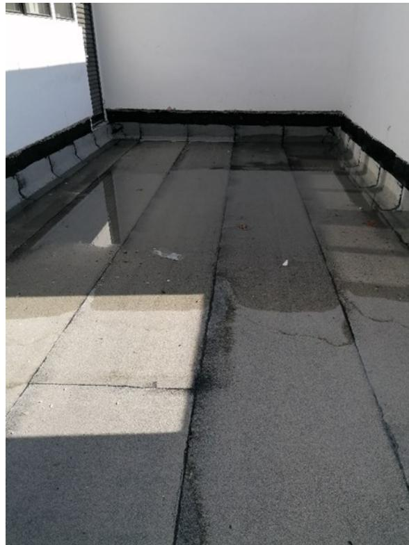
Slika 17. Bitumenski sloj na terasi X. kata, stanje u veljači 2022.
