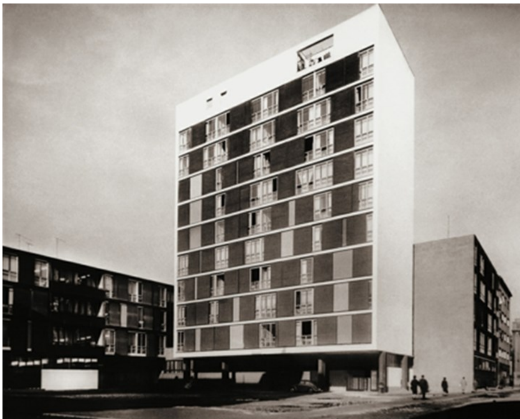
Slika 4. Sklop u Laganjinoj nakon izgradnje
