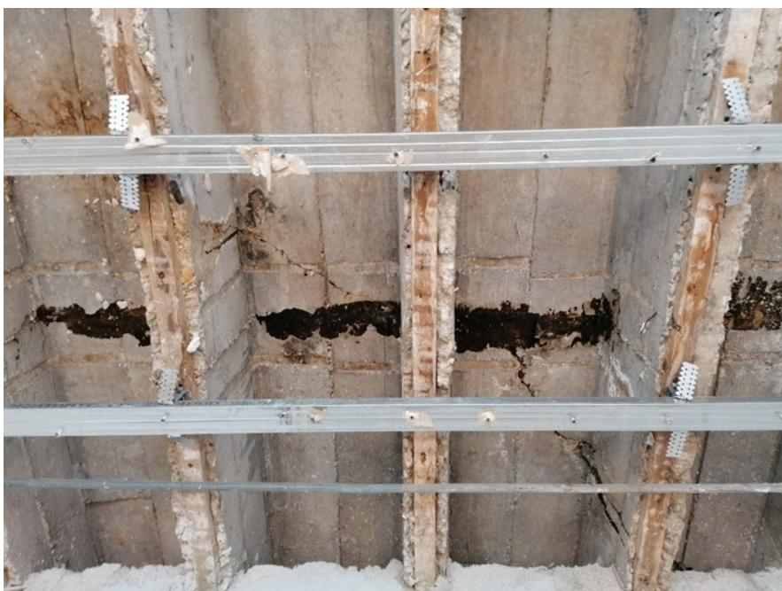
**Slika 16. Pukotina na stropnoj konstrukciji, stanje u veljači 2022.**
