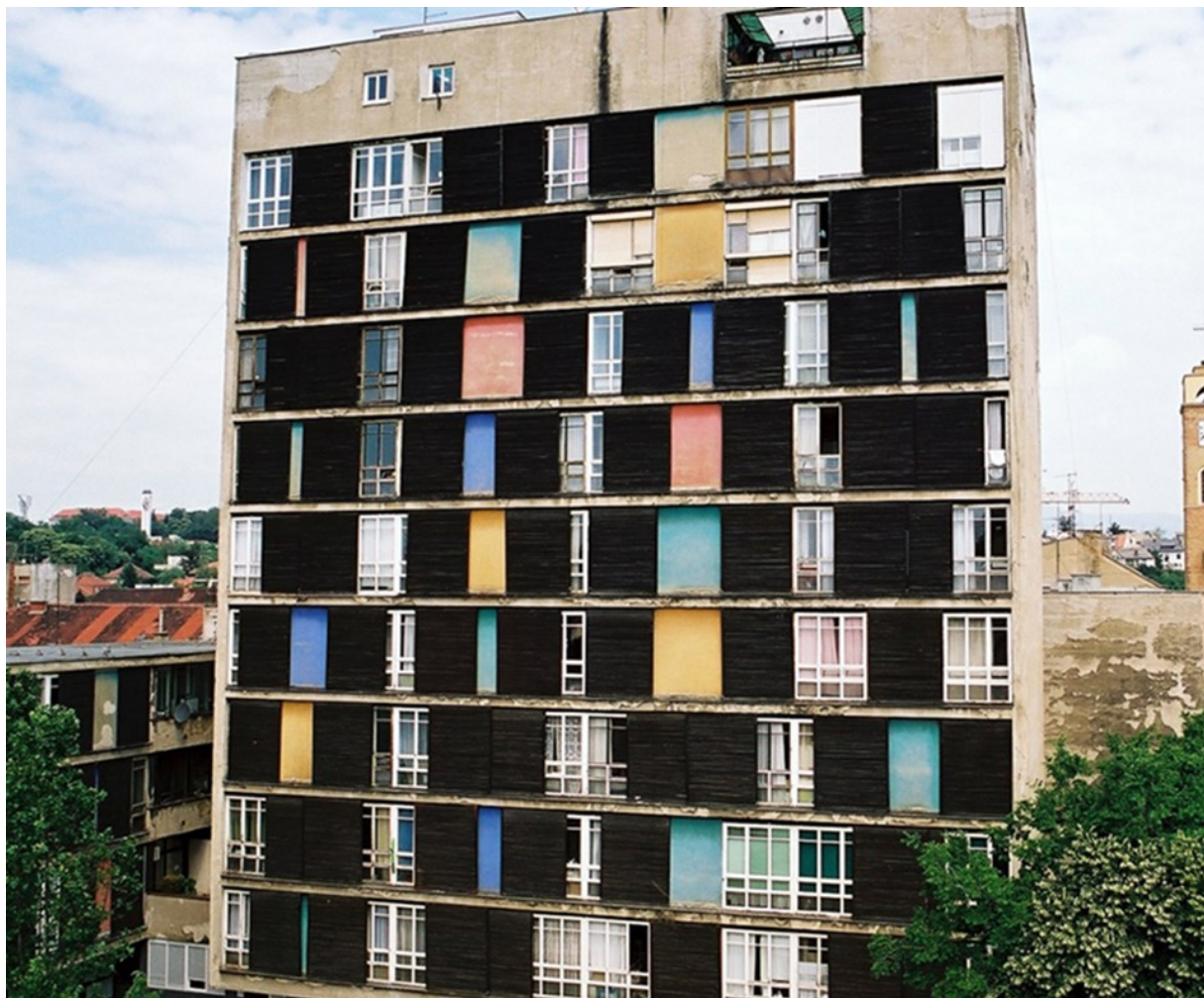
Slika 5. Vitićev sklop prije sanacije i obnove
