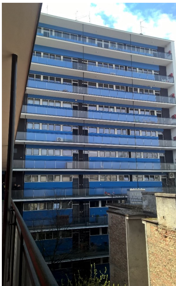
Slika 13. Pogled na sjeverno pročelje nebodera (2017.)
