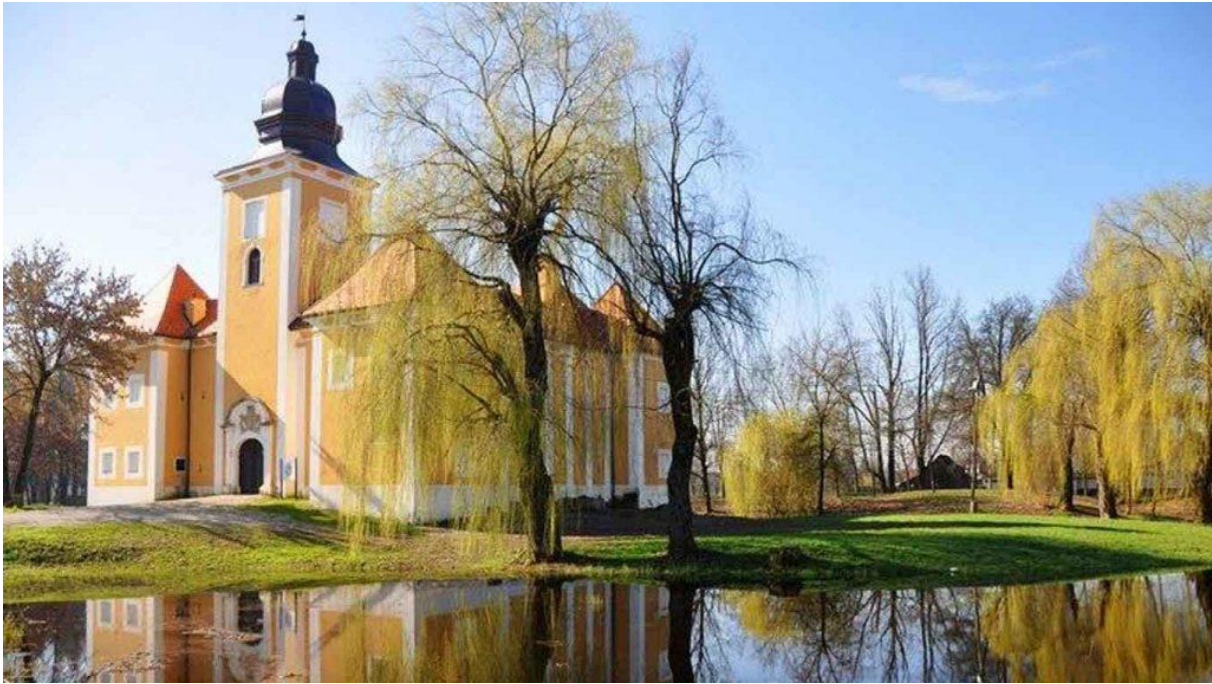
Sl. 18. Obnovljeni kaštel Lukavec
