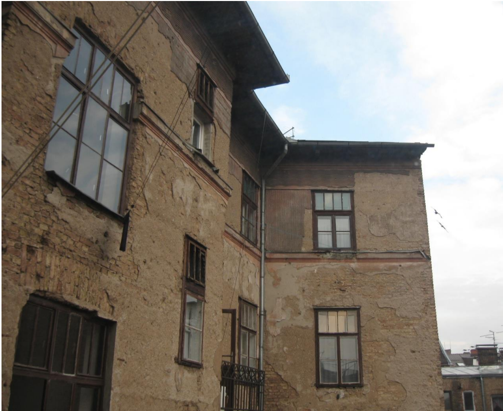
Slika br.96. Detalj, fasada sjevernog pročelja (unutrašnje dvorište), 2015.
