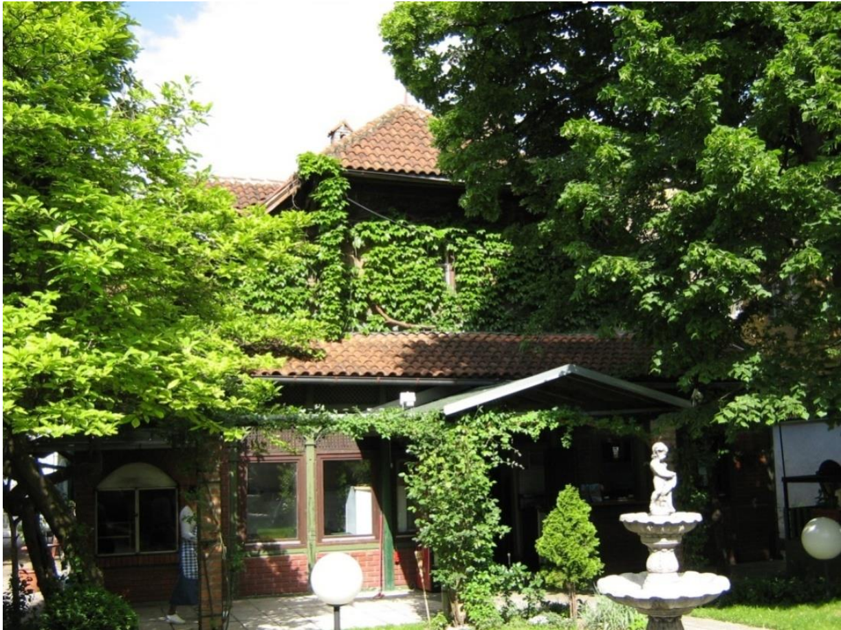
Slika br.27. Zgrada Miklau, unutrašnje dvorište, 2014.
