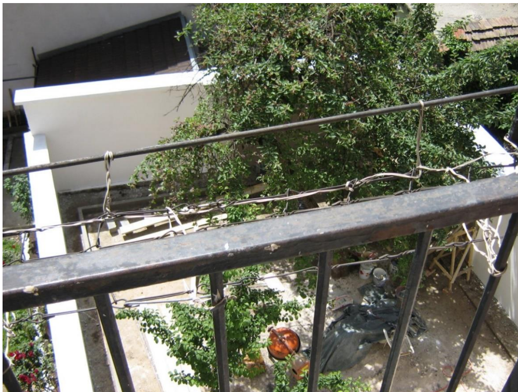
Slika br.166. Pogled na unutrašnje dvorište (Čurčić dio), 2014.
