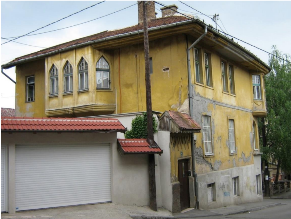
Slika br.172. Zgrada Nurudin bega Azapagića, zapadno pročelje, 2013.
