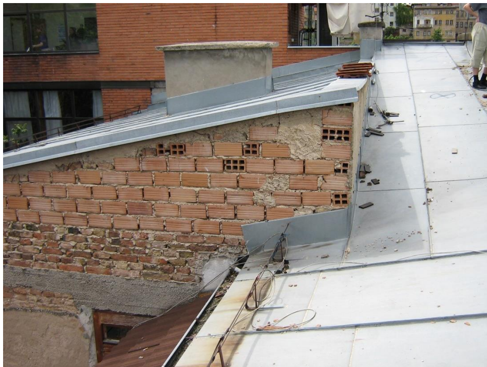
Slika br.118. Krov zgrade, 2014.
