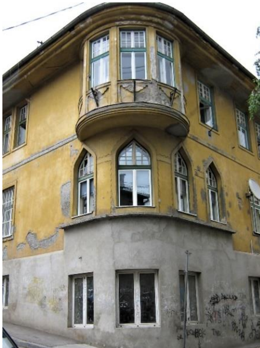
Slika br.175. Stambena zgrada Nurudin-bega Azapagića, 2014.
