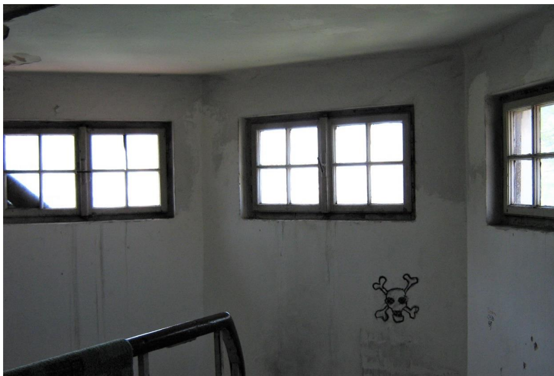
Slika br.110. Detalj stubišta mansarde, 2015.
