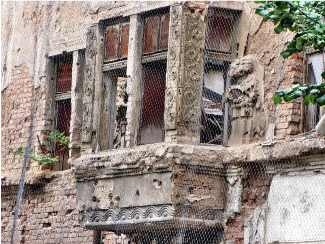
Slika br.124. Detalj erkera, zapadno pročelje, 2009.
