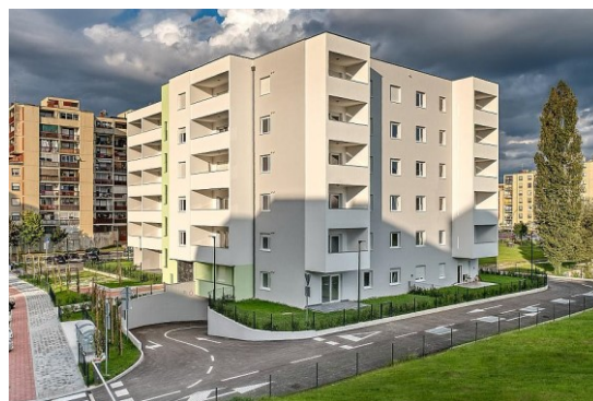
Slika 14. Stambena zgrada, gradska četvrt Grabrik, Karlovac
