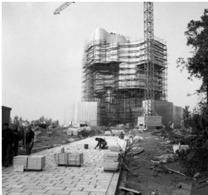
Slika 11. Izgradnja Spomenika na Petrovoj gori
