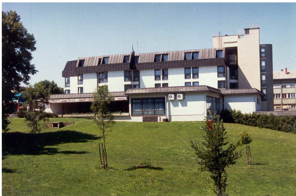
Slika 153. Istočno pročelje hotela
