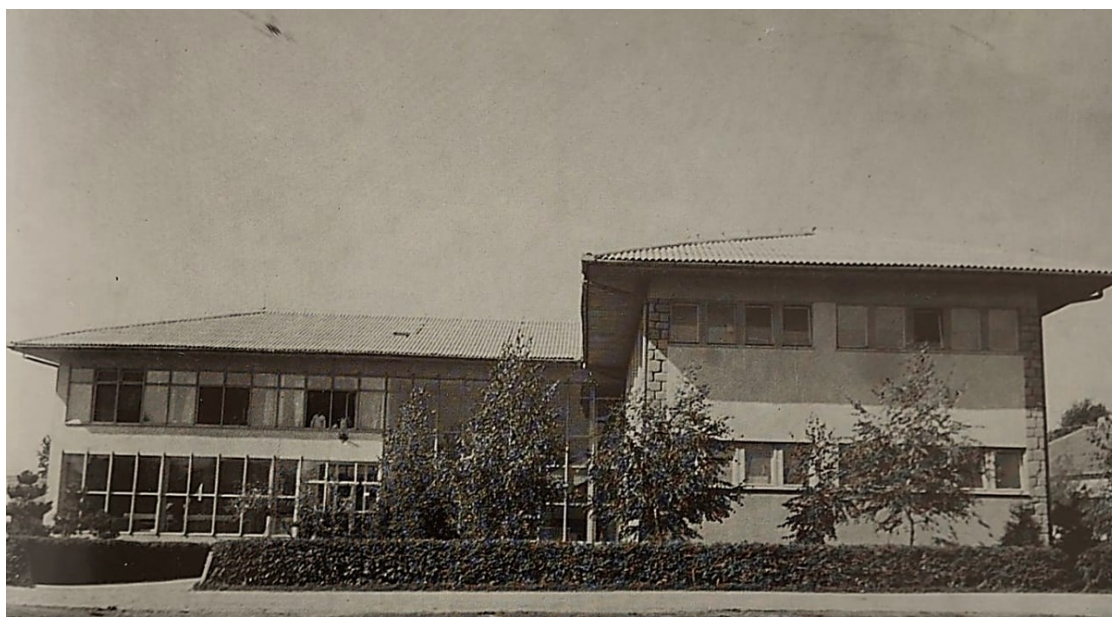
Slika 139. Istočno pročelje doma zdravlja nakon izgradnje
