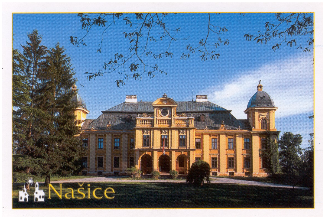
Slika 21. Dvorac obitelji Pejačević danas, južno (glavno) pročelje
