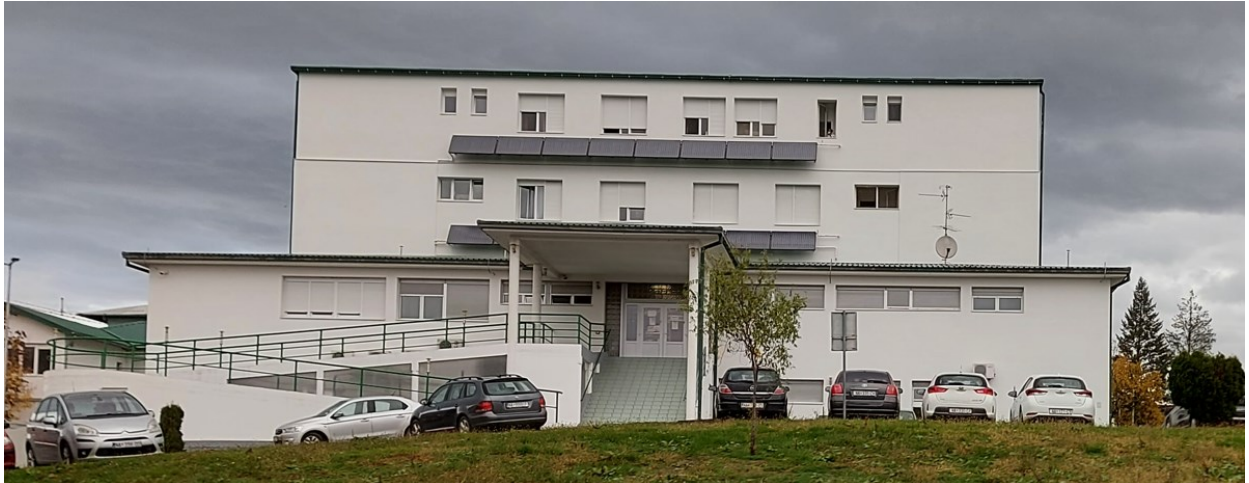
Slika 142. Južno pročelje bolnice
