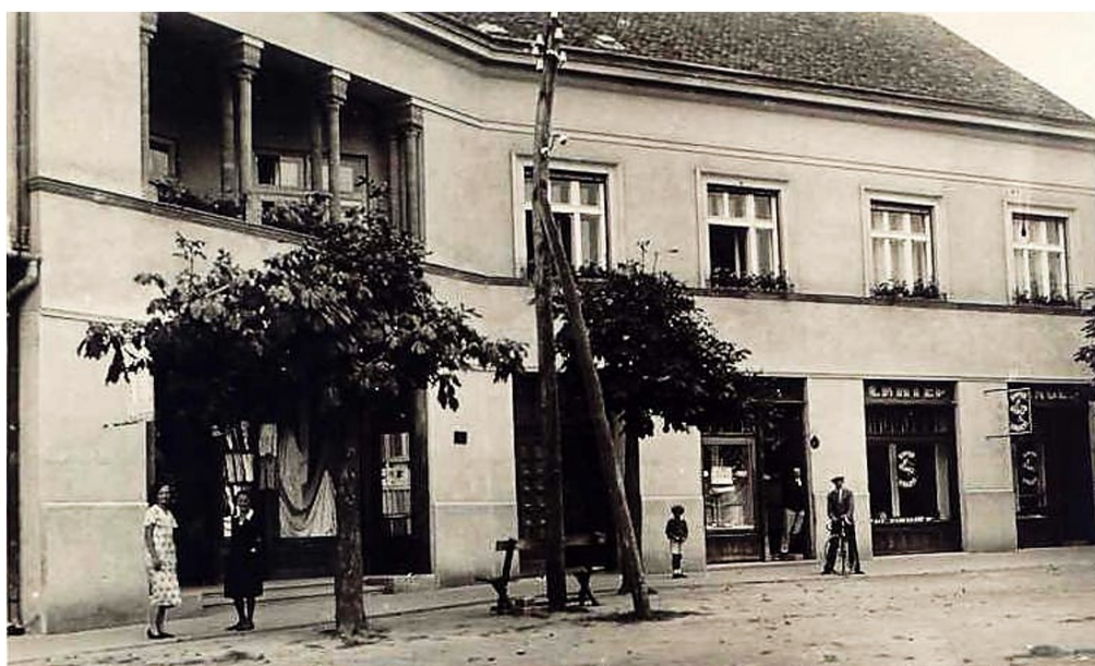
Slika 102. Glavno (sjeverno) pročelje kuće obitelji Hadžija
