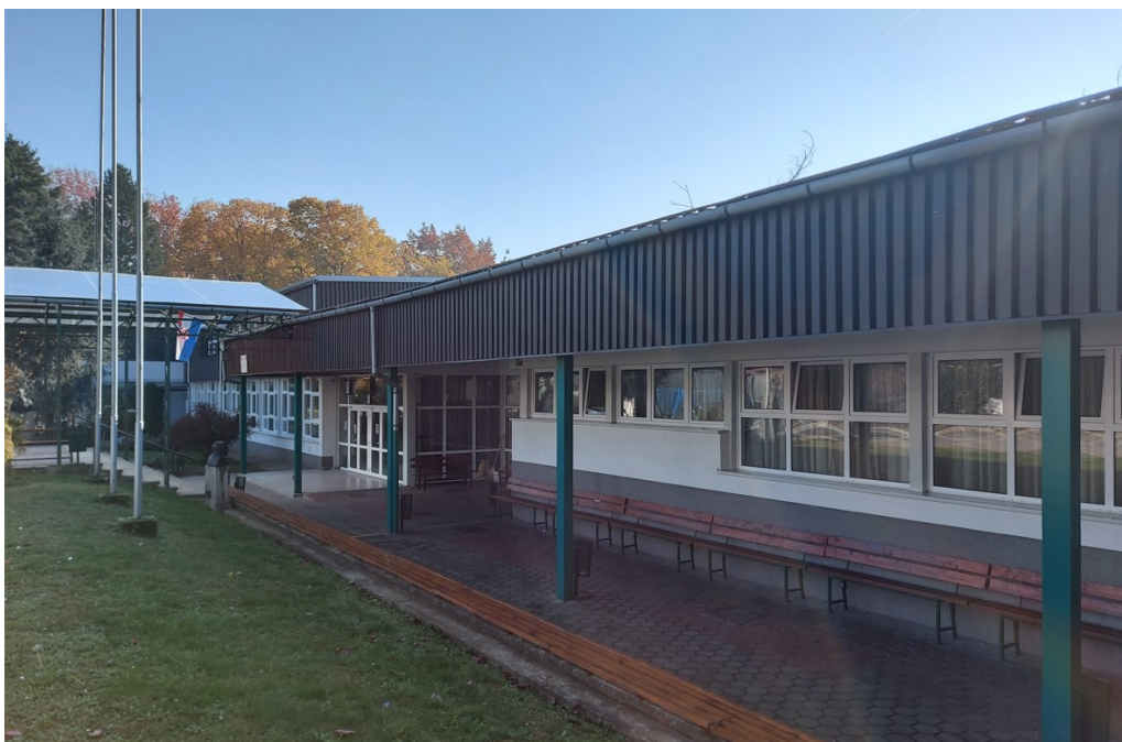
Slika 145. Pogled na sjeverno pročelje srednje škole
