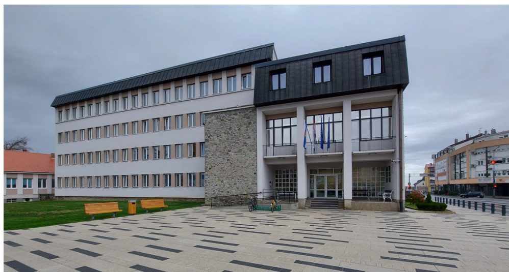
Slika 112. Glavno pročelje Gradske uprave - današnji izgled
