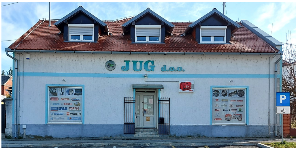
Slika 57. Nekadašnji objekt obitelji Drechsler u Ulici braće Radića na broju 66
