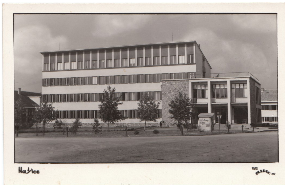
Slika 111. Glavno pročelje Gradske uprave - izvorni izgled
