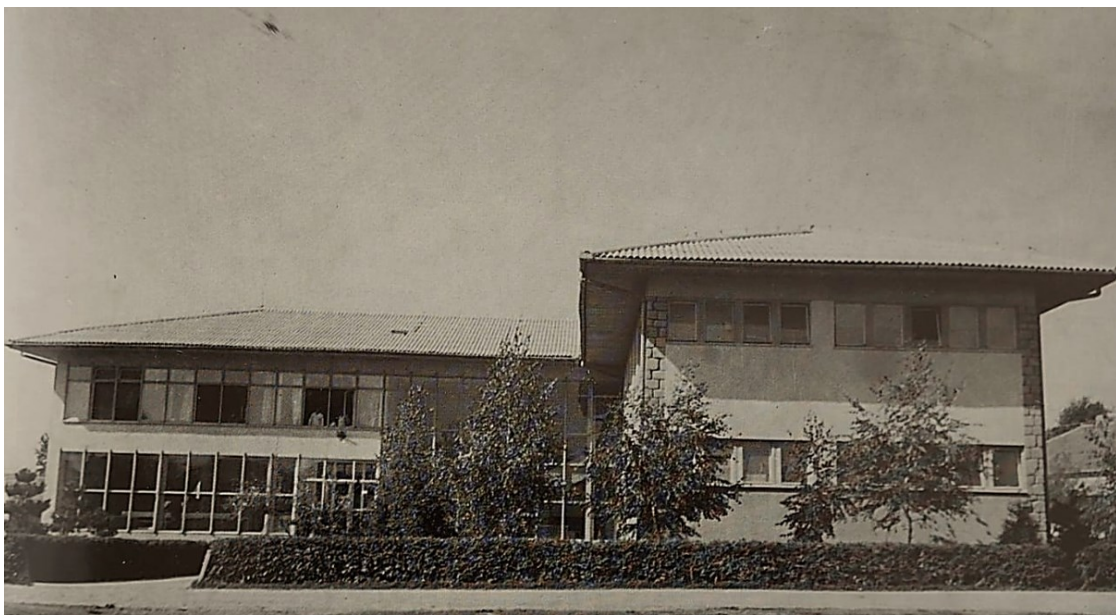
Slika 139. Istočno pročelje doma zdravlja nakon izgradnje
