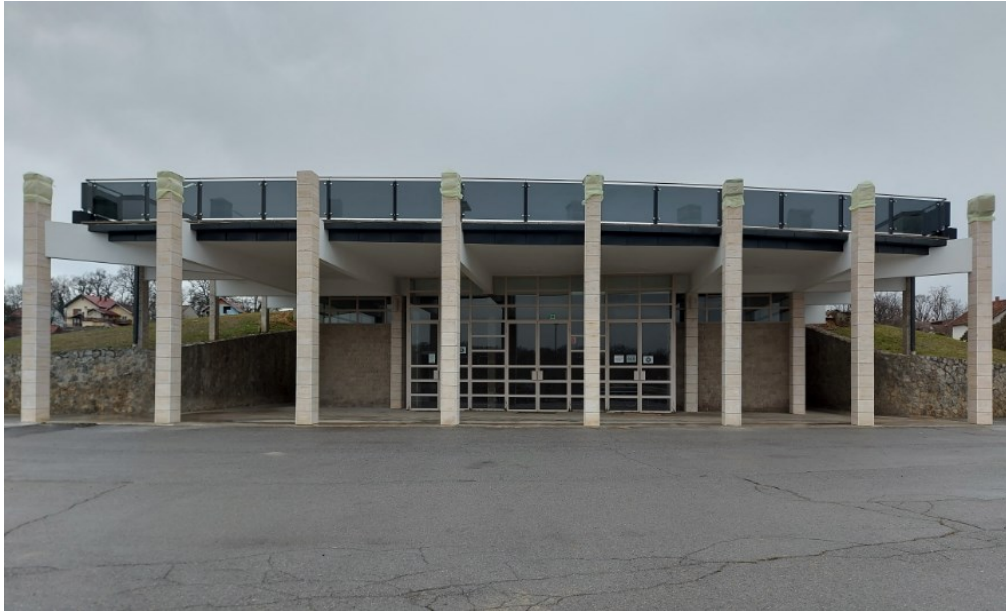
Slika 168. Mrtvačnica, glavno pročelje
