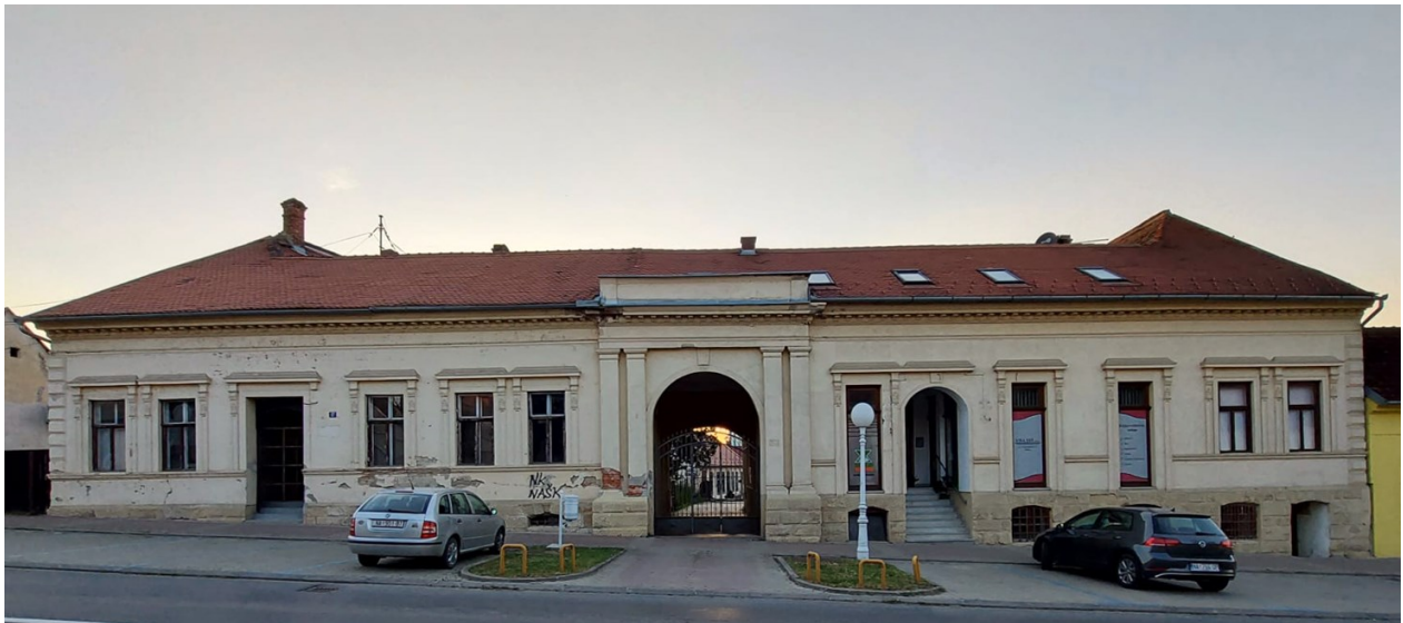
Slika 54. Glavno pročelje nekadašnje kuće obitelji Herzog (današnji izgled)
