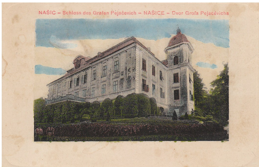
Slika 22. Dvorac obitelji Pejačević, sjeverno pročelje
