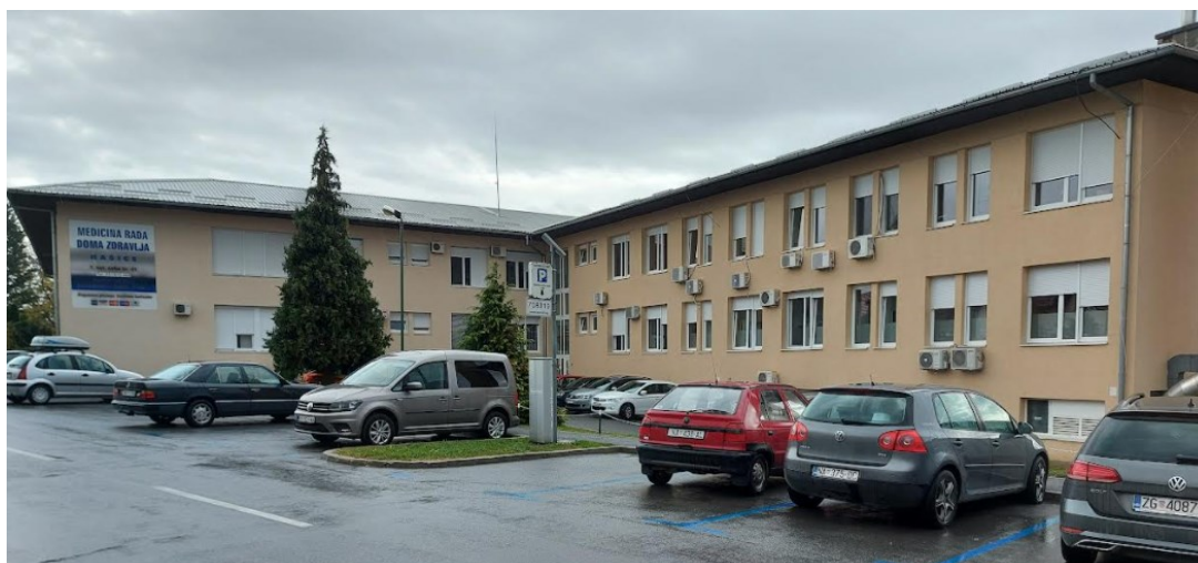
Slika 141. Pogled na zapadno i sjeverno pročelje doma zdravlja
