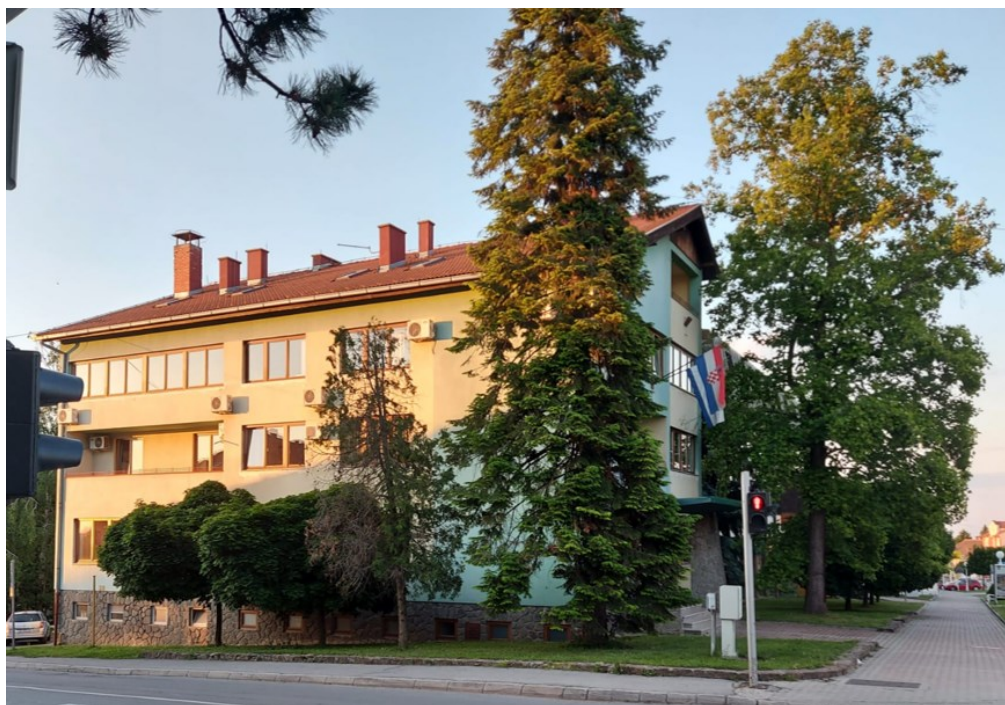
Slika 128. Pogled na zapadno pročelje šumarije - današnji izgled
