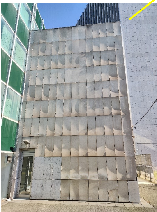
Slika 119, Slika 120 i Slika 121. Aneks Poslovnog tornja Zagrepčanka . Pogled s južne strane. Naznačena djelomična zamjena kamena na fasadi i izobličenja kamena.
