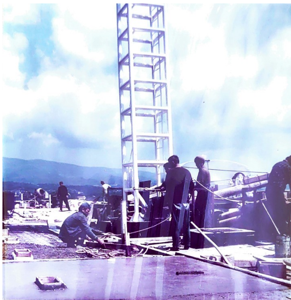
Slika 41. Montaža telekomunikacijskog tornja na vrhu Zagrepčanke
