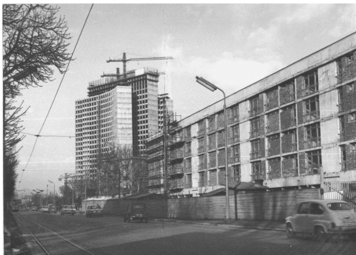
Slika 22. Zagrepčanka u izgradnji, fotograf Josip Vranić, 1973.
