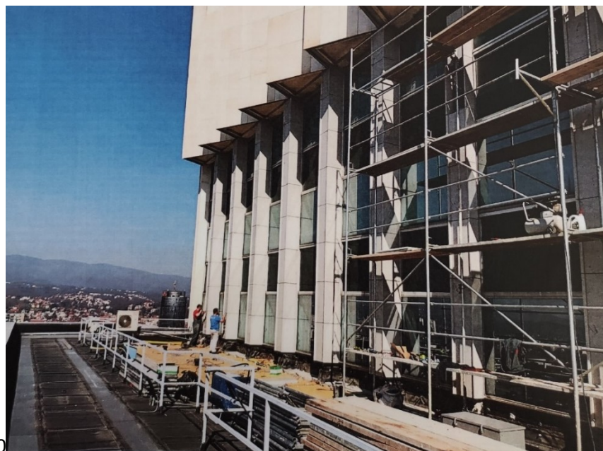
Slika 96. Obnavljanje stupova na terasi zapadnog pročelja Zagrepčanke, 2016. – 2018.
