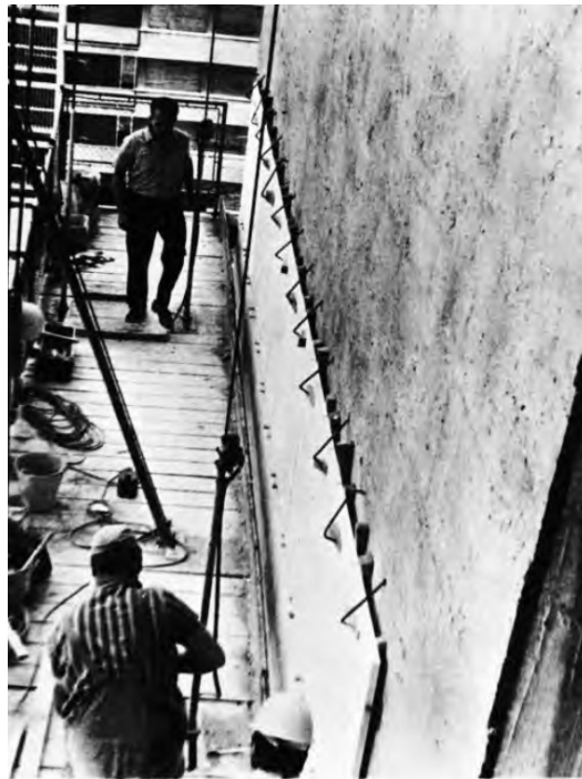
Slika 38. Oblaganje poslovnog tornja mramornim pločama
