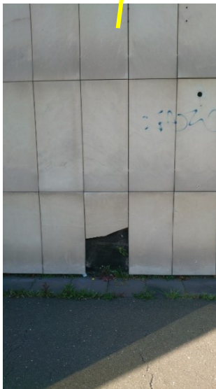
Slika 110, Slika 111, Slika 112, Slika 113. Aneks Poslovnog tornja Zagrepčanka. Pogled s južne strane. Naznačena oštećenja kamena na fasadi.
