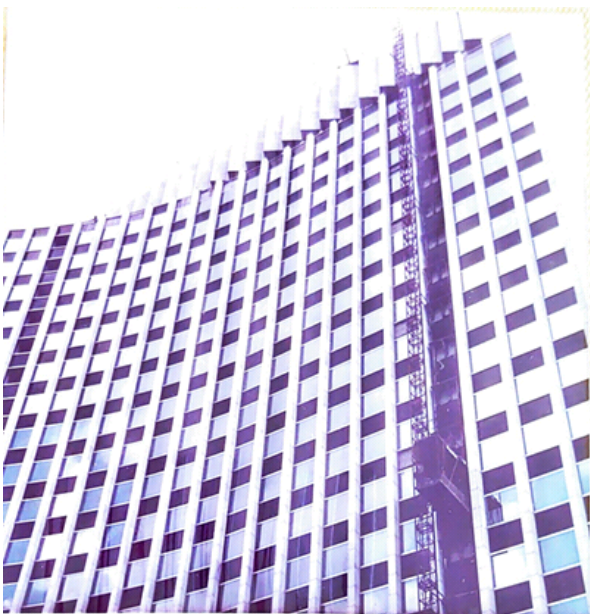
Slika 40. Uredaj za pranje fasade poslovnog tornja napravljen u Habegger-Thun , Austrija.
