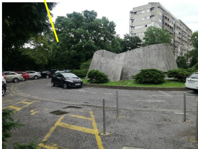
Slika 101, Slika 102 i Slika 103. Poslovni toranj Zagrepčanka . Pogled na sjevernu stranu građevine. Naznačen položaj rashladnog tornja i znaka o zabrani približavanja zbog opasnosti od padanja ploča.
