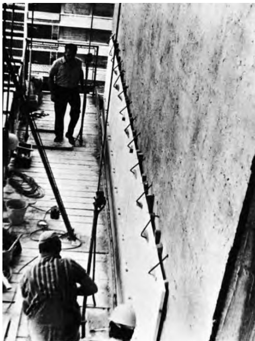
Slika 38. Oblaganje poslovnog tornja mramornim pločama
