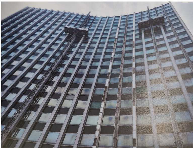
Slika 94. Obnavljanje istočnog pročelja Zagrepčanke, 2014. – 2016.
