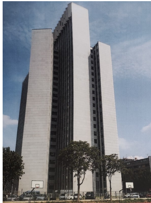
Slika 98. Južno pročelje Zagrepčanke nakon obnove, 2018.
