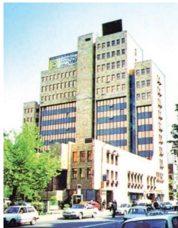
Slika 79. Poslovna zgrada Zoil Makedonija u Skopju, arhitekti Kiril Muratovski i Miroslav Sidovski, dovršeno 1978.
