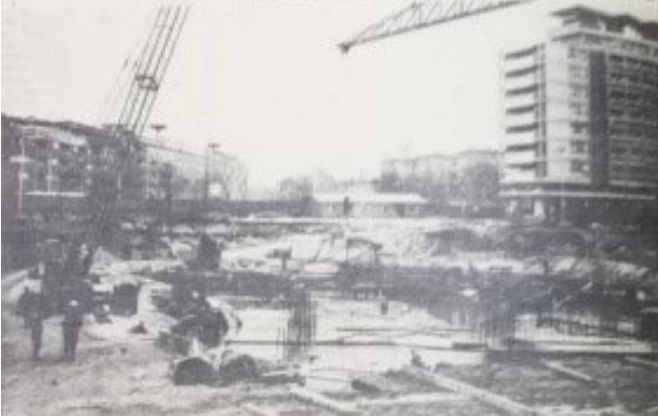
Slika 20. Postavljanje temelja za poslovni toranj. Fotografirano u pravcu sjevera. S desne strane vidi se višestambena zgrada nekadašnje Vojne pošte u Ulici grada Vukovara (projekt napravio Stanko Fabris, sagrađena 1957.) 135
