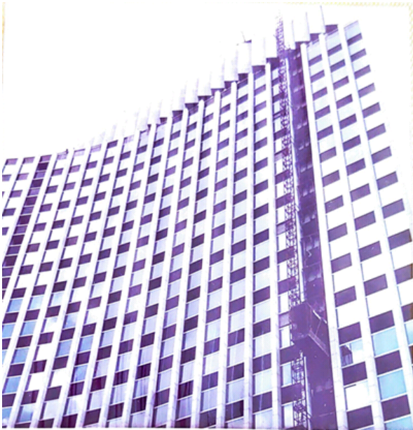
Slika 40. Uređaj za pranje fasade poslovnog tornja napravljen u Habegger-Thun , Austrija.
