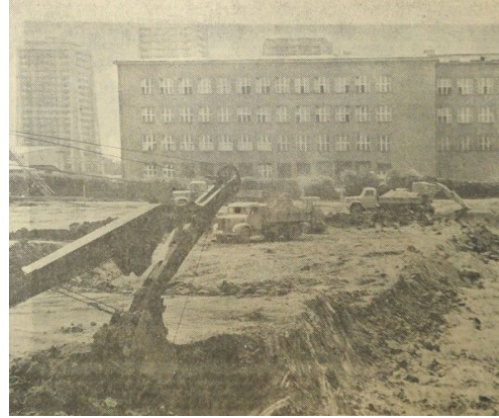
Slika 21. Postavljanje temelja za poslovni toranj. Fotografirano u pravcu juga. U pozadini vidi se zgrada Ženske realne gimnazije sestara milosrdnica – danas Učiteljski fakultet na Savskoj cesti (projekt napravio Zvonimir Vrkljan, sagrađena 1937. – 1939.) 136
