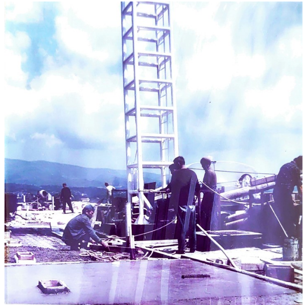
Slika 41. Montaža telekomunikacijskog tornja na vrhu Zagrepčanke
