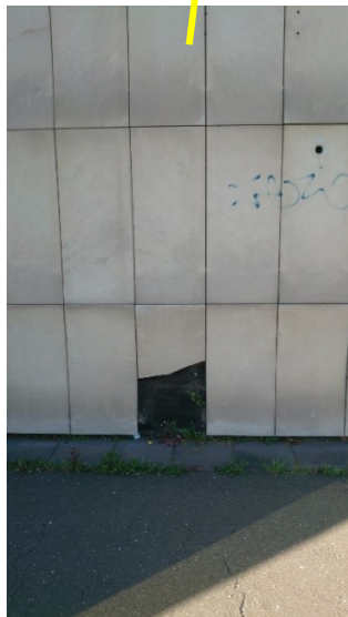
Slika 110, Slika 111, Slika 112, Slika 113. Aneks Poslovnog tornja Zagrepčanka. Pogled s južne strane. Naznačena oštećenja kamena na fasadi.
