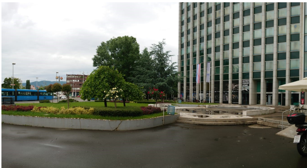
Slika 106. Javni prostor ispred Poslovnog tornja Zagrepčanka .
