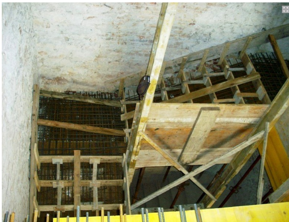
sl. 109. Drvena oplata s armaturom, unutar koje će se izvesti novo, armiranobetonsko stubište, koje će zamijeniti uklonjeno kameno. Fotografirano tijekom obnove zgrade koja je trajala od 2008. do 2015. godine
