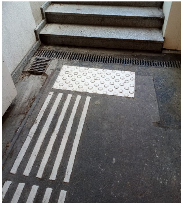
sl. 76. Podne trake za lakše kretanje slijepih osoba. Snimljeno u pothodniku u zagrebačkoj Aveniji Dubrovnik. Iste bi se mogle postaviti i na nogostupe ulica u Metkoviću, pa i onih u neposrednoj okolici tamošnjeg Prirodoslovnog muzeja
