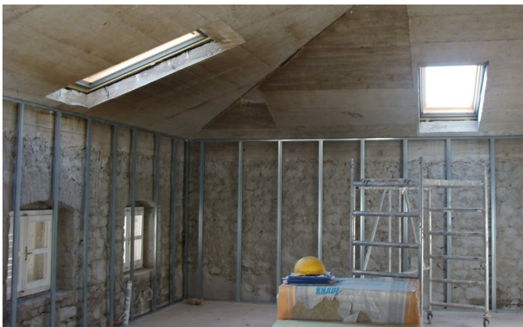
sl. 91. Dio tavana bivše zgrade uprave i stanovanja duhanske stanice u Metkoviću, danas Prirodoslovnog muzeja i Gradske knjižnice, fotografiran tijekom trajanja obnove zgrade u razdoblju od 2008. do 2015. godine. Vidljivi su obnovljeni mali pravokutni prozori na vanjskom zidu te novi i veći, također pravokutni prozori na krovu
