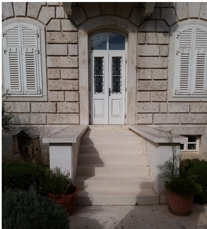
sl. 96. Nekad glavni, a danas sporedni i evakuacijski ulaz na istočnom pročelju zgrade Prirodoslovnog muzeja i Gradske knjižnice, koji se koristi samo u slučaju nužde
