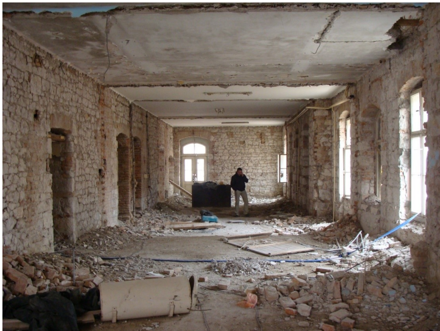
sl. 86. Dio unutrašnjosti zgrade uprave i stanovanja (danas Prirodoslovnog muzeja i Gradske knjižnice) duhanske stanice u Metkoviću, fotografirana tijekom trajanja njezine obnove u razdoblju od 2008. do 2015. godine. Vidljivo je unutarne lice vanjskog zida izvedeno od cigli i nepravilnog kamena različitih dimenzija, s kojih je uklonjena žbuka
