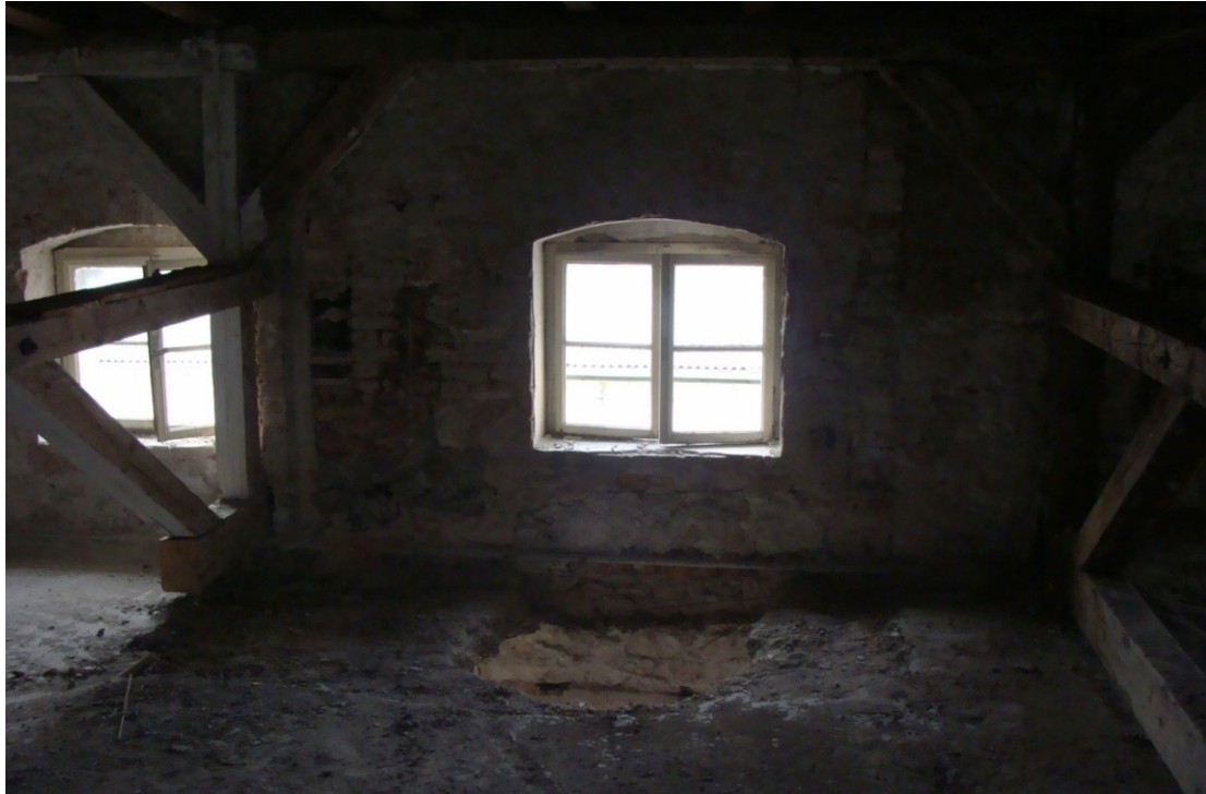
sl. 89. Mali tavanski prozori oblika kraćeg polegnutog pravokutnika bivše zgrade uprave i stanovanja duhanske stanice u Metkoviću, danas Prirodoslovnog muzeja i Gradske knjižnice
