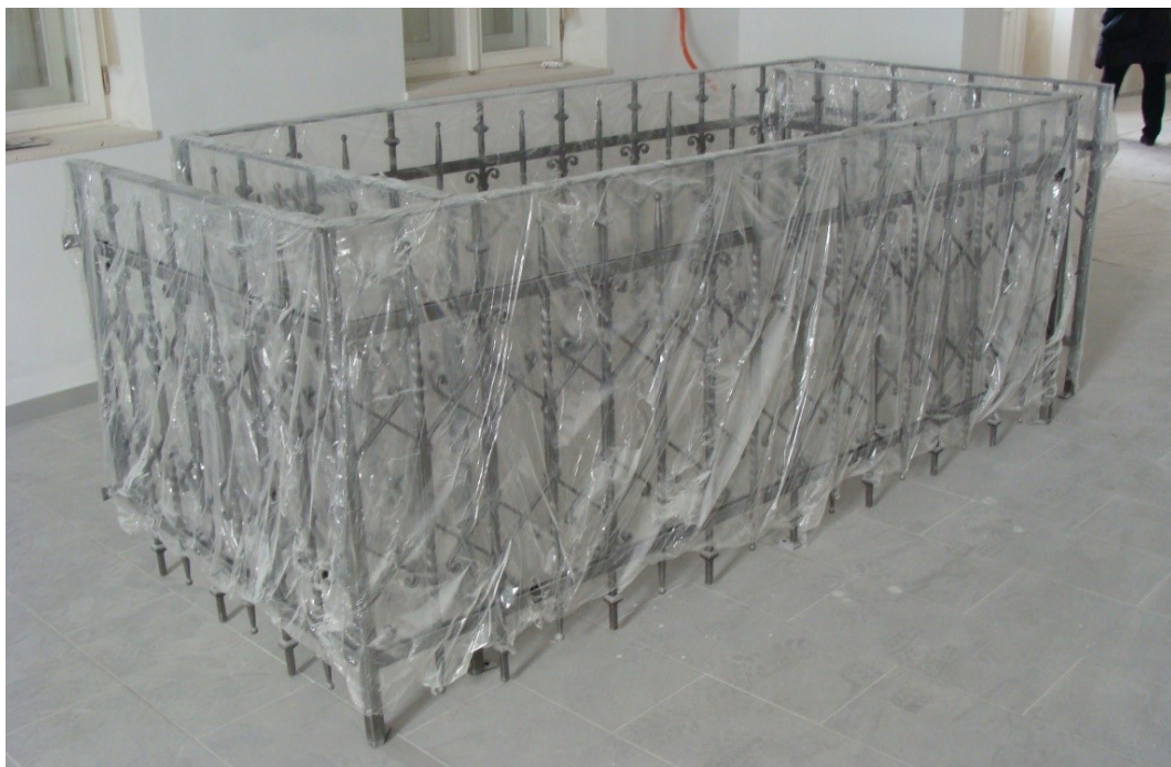
sl. 100. Nova čelična ograda napravljena za balkone bivše zgrade uprave i stanovanja duhanske stanice u Metkoviću, danas Prirodoslovnog muzeja i Gradske knjižnice, koja kopira staru
