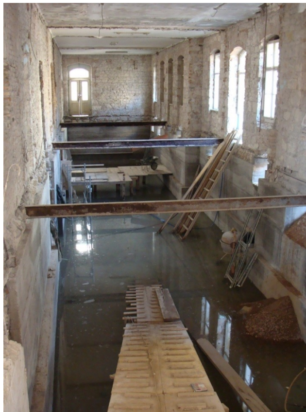
sl. 134. Poplavljen prostor suterena zgrade uprave i stanovanja i stanovanja duhanske stanice u Metkoviću, danas Prirodoslovnog muzeja i Gradske knjižnice. Fotografirano tijekom obnove zgrade koja je trajala od 2008. do 2015. godine
