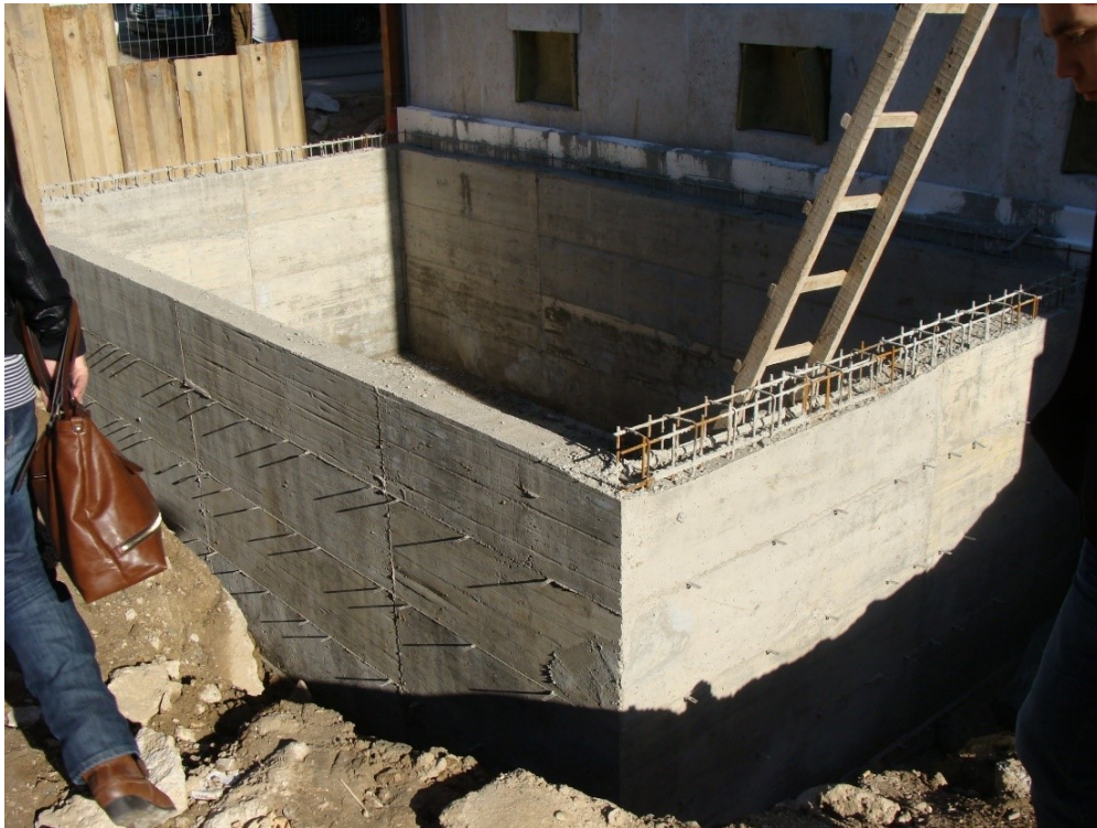
sl. 131. „Bazen“ za klimatizacijske jedinice Prirodoslovnog muzeja u Metkoviću, snimljen u procesu građenja. Fotografirano tijekom obnove zgrade koja je trajala od 2008. do 2015. godine
