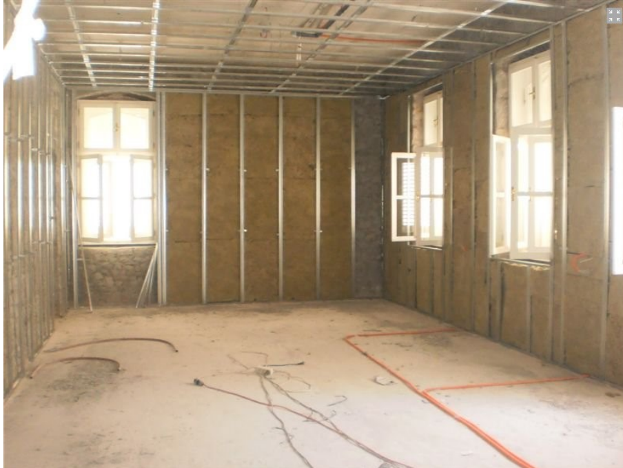
sl. 87. Aluminijska podkonstrukcija montirana na unutrašnje strane vanjskih zidove prvog kata zgrade Prirodoslovnog muzeja i Gradske knjižnice, na koje će se postaviti mineralna vuna. Fotografirano tijekom obnove zgrade koja je trajala od 2008. do 2015. godine
