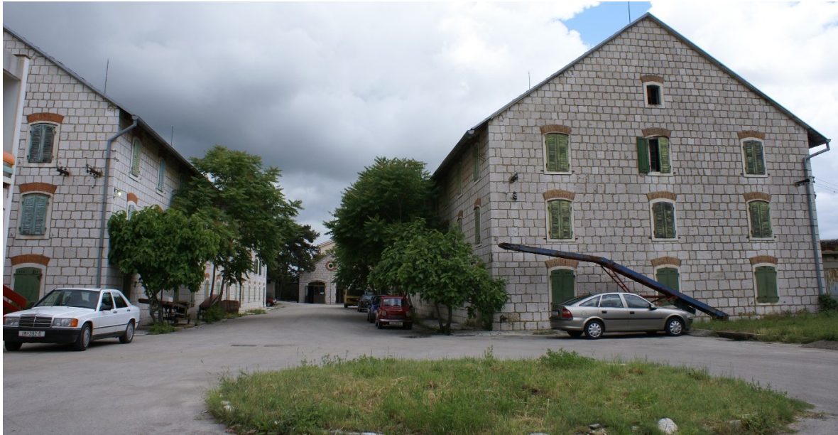
sl. 47. Prva dva (od ukupno četiri) skladišta duhana duhanske stanice u Imotskom. Snimljeno sa sjeverozapada prema jugoistoku, tj. sjeverozapadnim pročeljima skladišta
