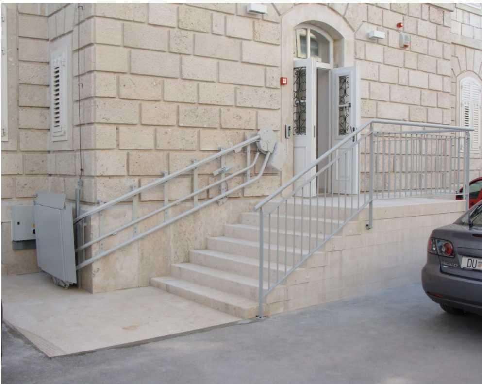
sl. 92. Prilaz glavnom ulazu Prirodoslovnog muzeja i Gradske knjižnice u Metkoviću, pogled sa sjeverozapadne strane na sjeverni dio ulaznog stepeništa. Osim njega, na slici je vidljiva i kosa stubišna platforma za osobe u invalidskim kolicima, ograda s rukohvatom te dvokrilna ulazna vrata. Fotografirano pri kraju ili nedugo nakon završetka obnove koja je trajala od 2008. do 2015.
