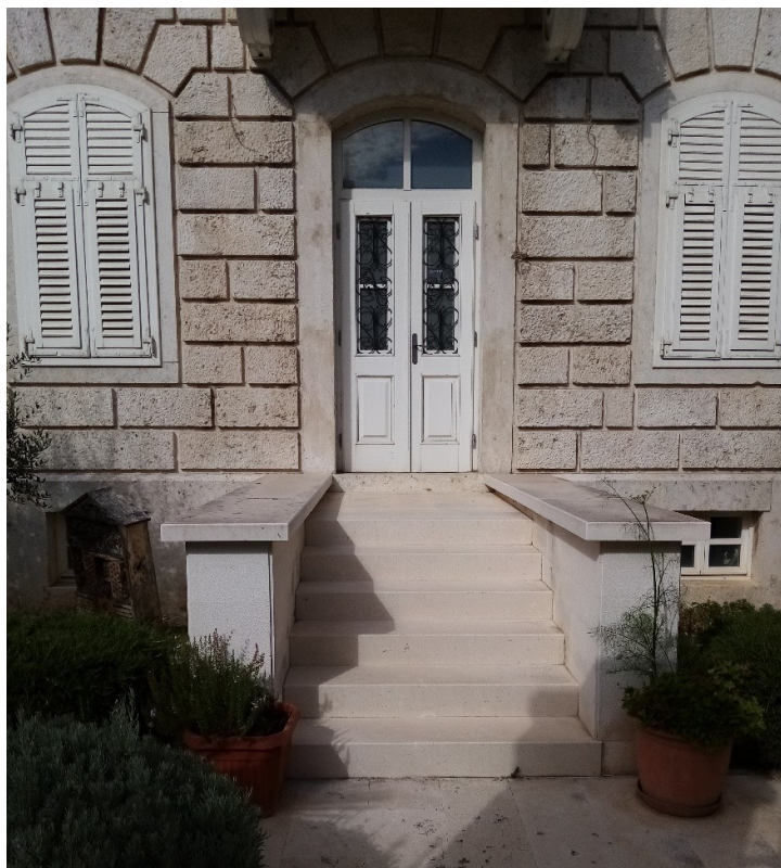
sl. 96. Nekad glavni, a danas sporedni i evakuacijski ulaz na istočnom pročelju zgrade Prirodoslovnog muzeja i Gradske knjižnice, koji se koristi samo u slučaju nužde
