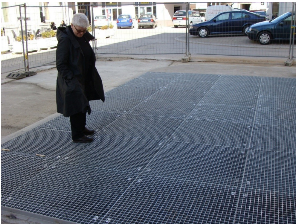
sl. 132. Površinska čelična rešetka (mreža) „bazena“ za klimatizacijske jedinice Prirodoslovnog muzeja u Metkoviću. Fotografirano pri kraju ili nedugo nakon završetka obnove koja je trajala od 2008. do 2015.
