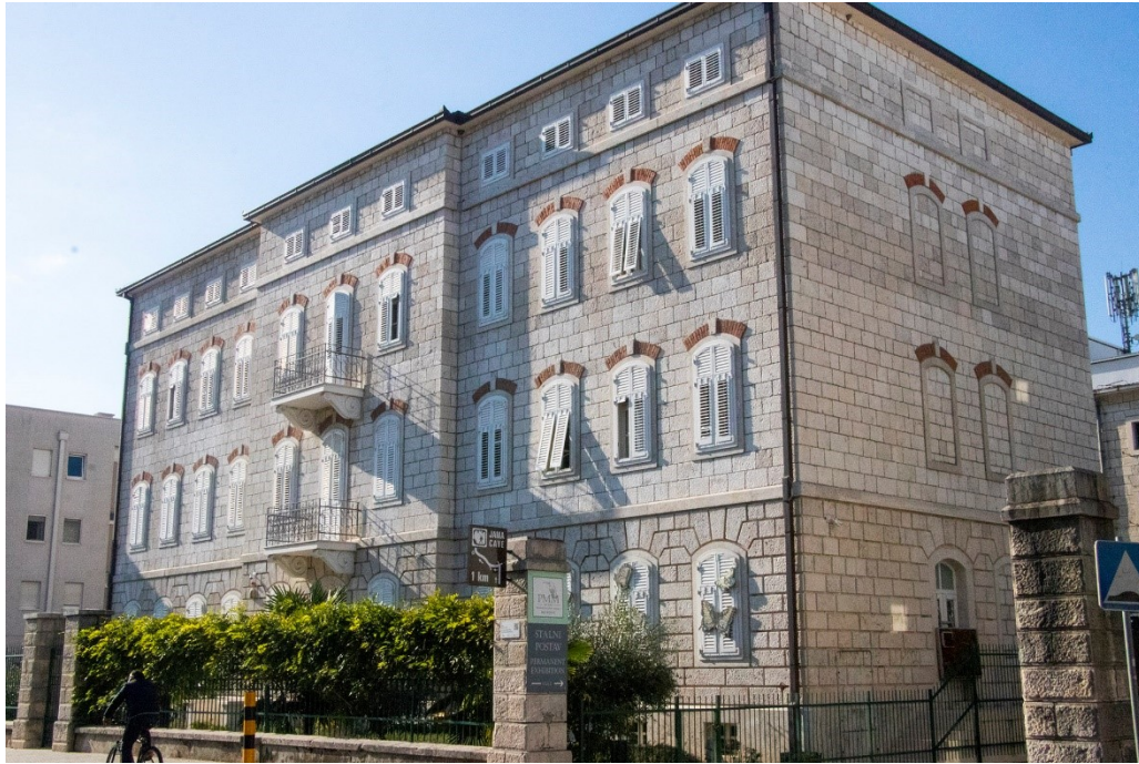
sl. 107. Pogled na istočno i sjeverno pročelje bivše zgrade uprave i stanovanja duhanske stanice u Metkoviću, danas Prirodoslovnog muzeja i Gradske knjižnice
