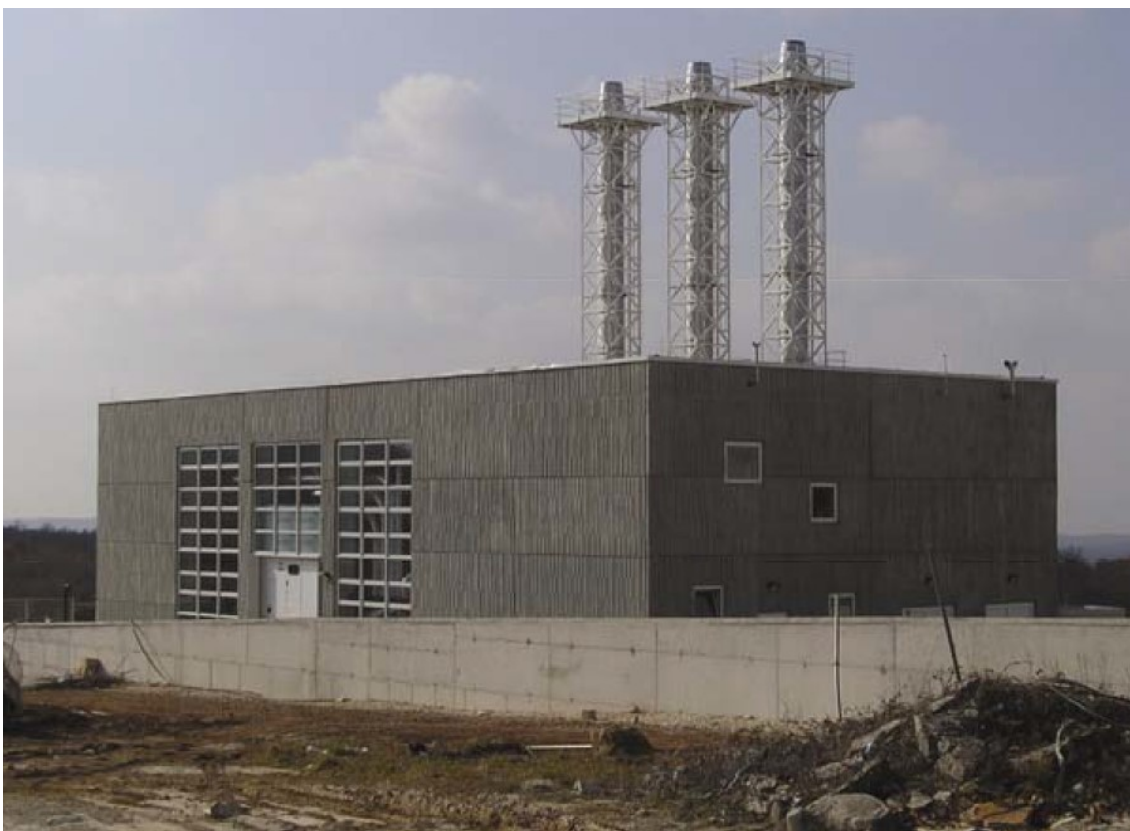
sl. 20. Kotlovnica suvremene tvornice duhana u Kanfanaru
