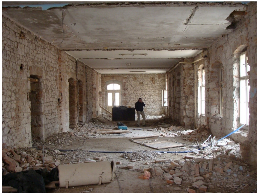
sl. 86. Dio unutrašnjosti zgrade uprave i stanovanja (danas Prirodoslovnog muzeja i Gradske knjižnice) duhanske stanice u Metkoviću, fotografirana tijekom trajanja njezine obnove u razdoblju od 2008. do 2015. godine. Vidljivo je unutarne lice vanjskog zida izvedeno od cigli i nepravilnog kamena različitih dimenzija, s kojih je uklonjena žbuka
