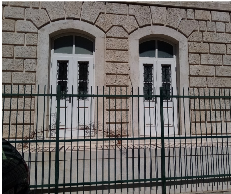
sl. 98. Bočni ulazi na jednom od bočnih pročelja zgrade Prirodoslovnog muzeja i Gradske knjižnice
