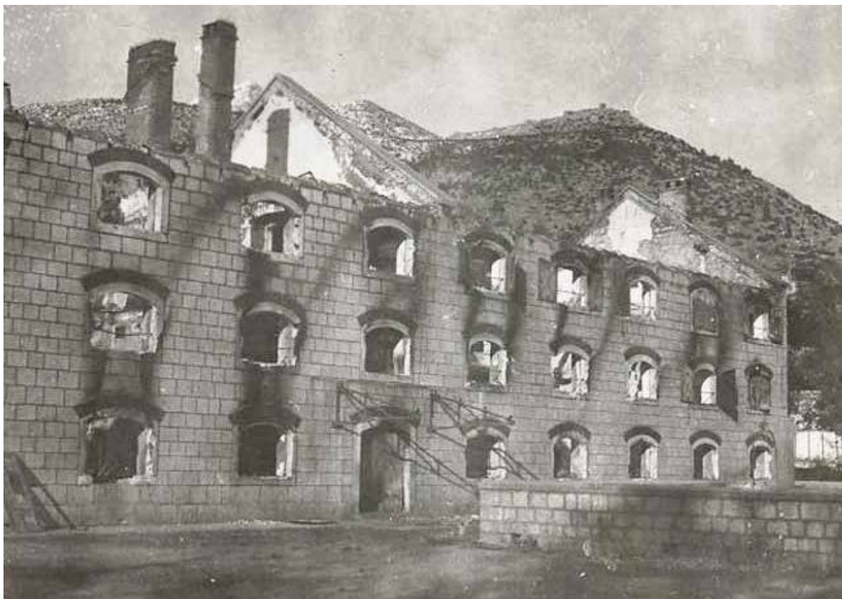
sl. 3. Požarom oštećena skladišna zgrada bivše duhanske stanice u Vrgorcu. Snimljeno sredinom 20. stoljeća, tj. u vrijeme ili neposredno nakon Drugog svjetskog rata
