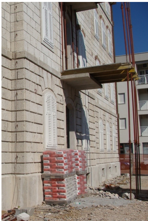
sl. 101. Jedan od balkona istočnog pročelja zgrade, fotografiran tijekom njihove rekonstrukcije tijekom trajanja obnove zgrade u razdoblju od 2008. do 2015. godine
