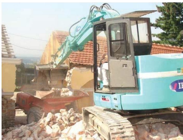
Slika 63. Uklanjanje urušenog materijala
