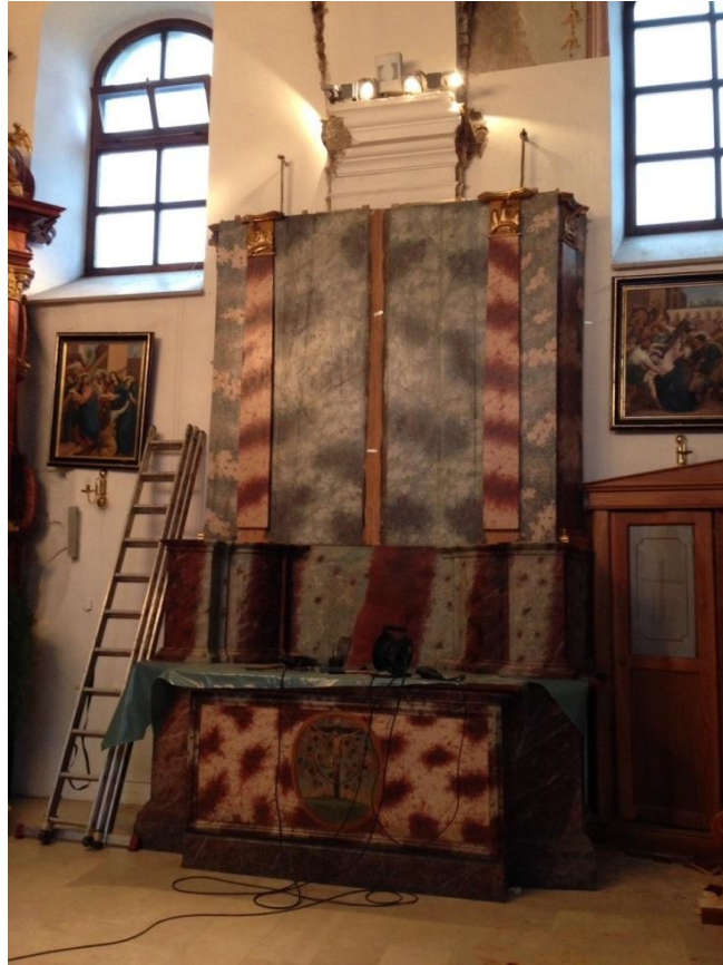
Slika 89. Proces montiranja oltara na izvornu poziciju (snimljeno 2014.)
