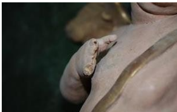
Slika 86. Detalj oštećenja anđela u zoni atike oltara Sv. Križa
