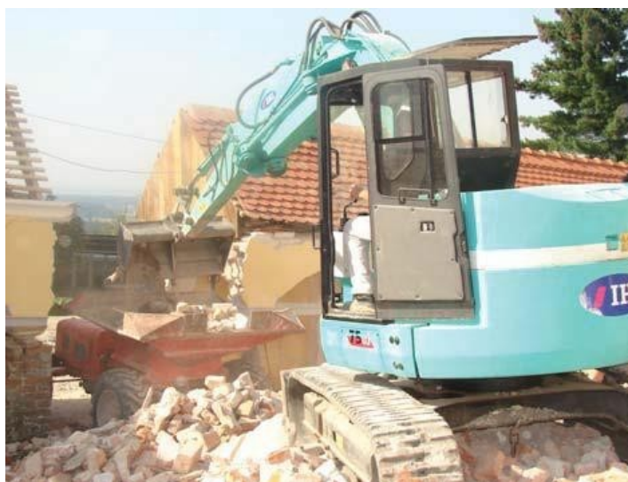
Slika 63. Uklanjanje urušenog materijala
