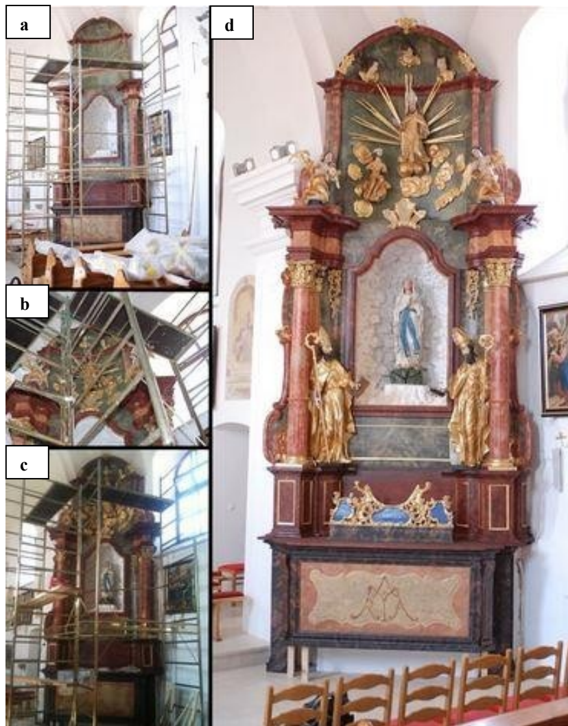
Slika 93 a-d. Montaža oltara Majke Božje Lurdske na izvornu poziciju
