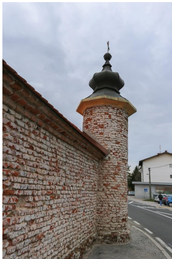
Slika 71. Pogled na zid i slijepu kulu cinktora čiji su radovi još u tijeku (snimljeno 2021.)
