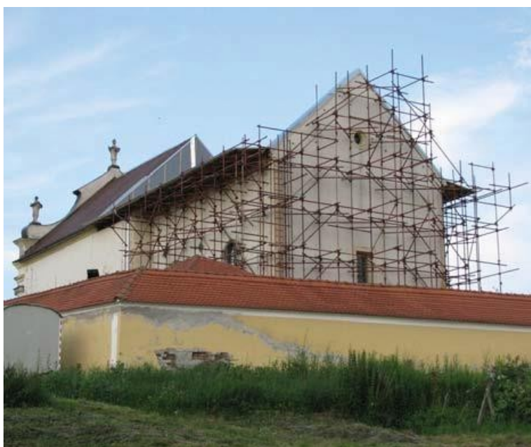
Slika 64. Podupiranje trijumfalnog luka i pridržanje zidova svetišta
