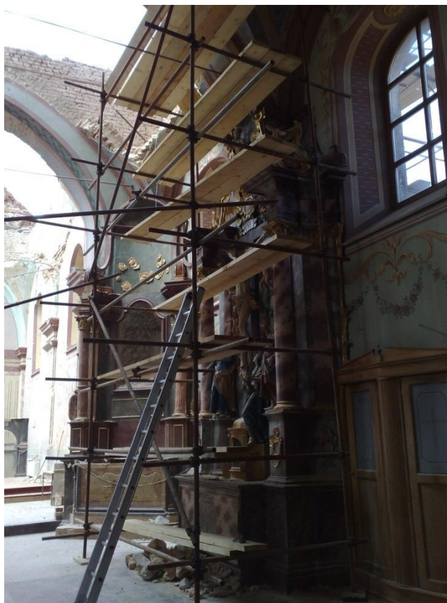
Slika 74. Demontaža preostalog inventara iz ruševina crkve (snimljeno 2008.)
