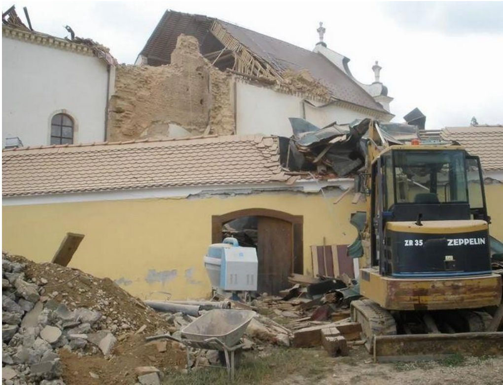
Slika 70. Oštećenje na cinktoru (snimljeno 2008.)
