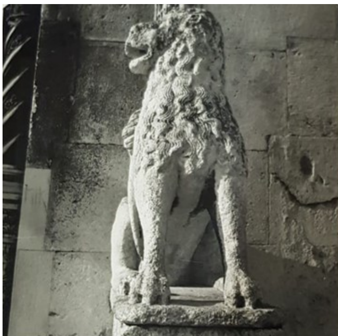
Slika 10. Detalj sjevernog portala, oštećenja kamena uslijed djelovanja (snimljeno 1971. godine), u: Ministarstvo kulture i medija – Središnja dokumentacija kulturne baštine, Zbirka elaborata zaštitnih radova 1756, 1971.
