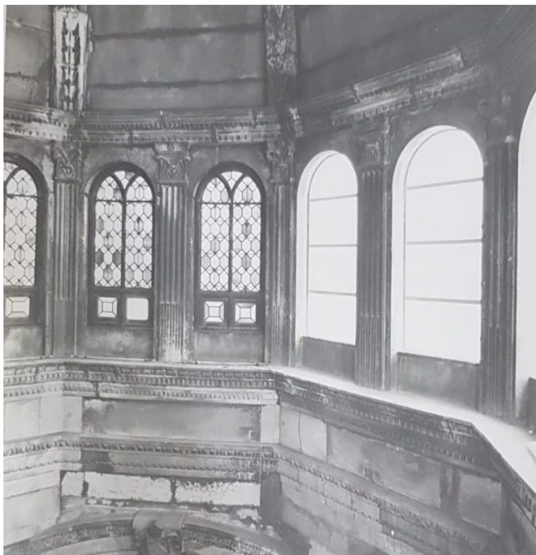
Slika 15. Prozori kupole, lijevo: ostakljenje iz 1890. godine; desno: ostakljenje iz 1982. godine, u: Ministarstvo kulture i medija – Središnja dokumentacija kulturne baštine, Zbirka elaborata zaštitnih radova 2080, 1987.
