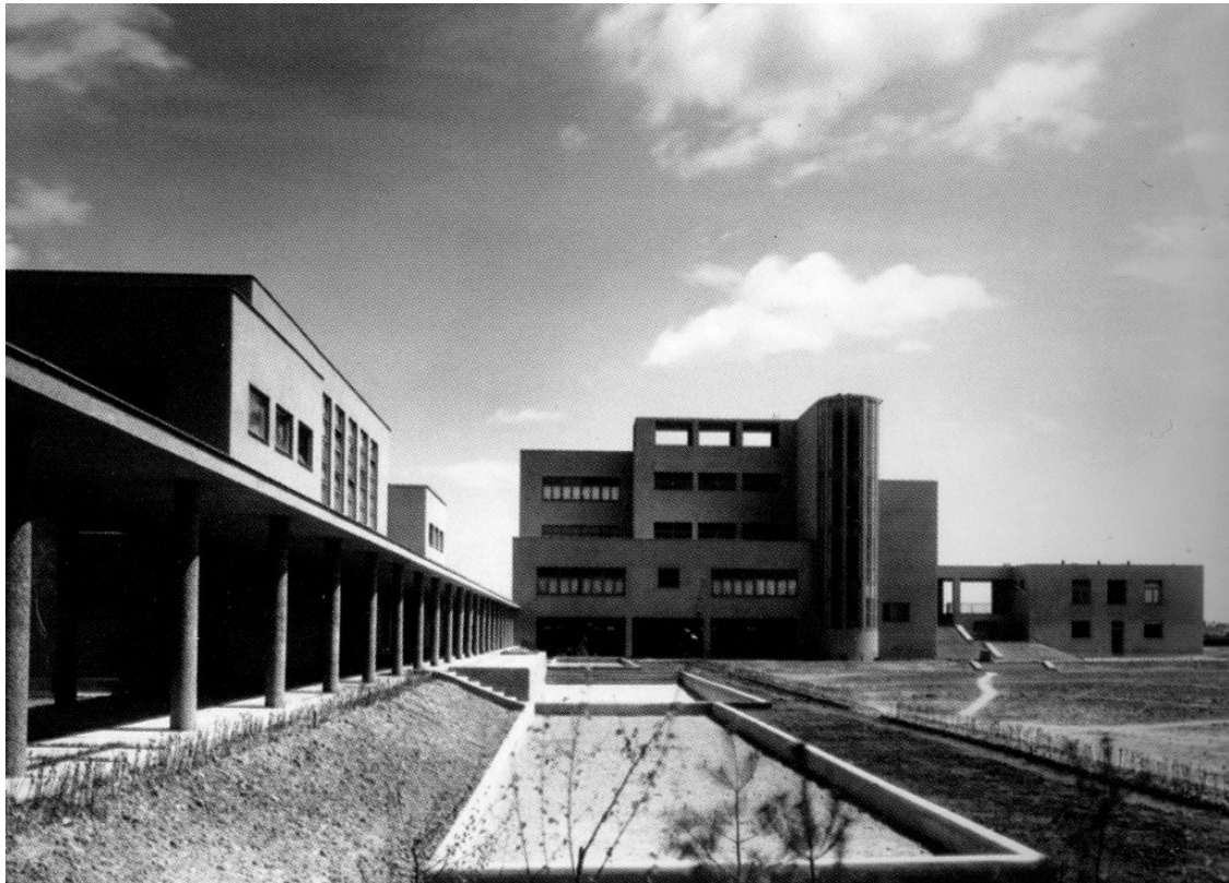
Slika 1. izgradnja škole na Selskoj cesti
