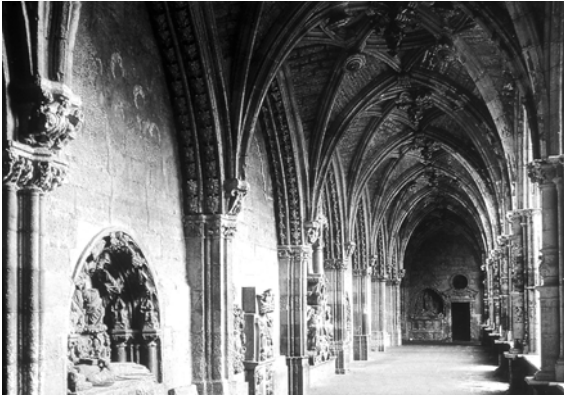
Figura 10. Catedral de León, interior del claustro
