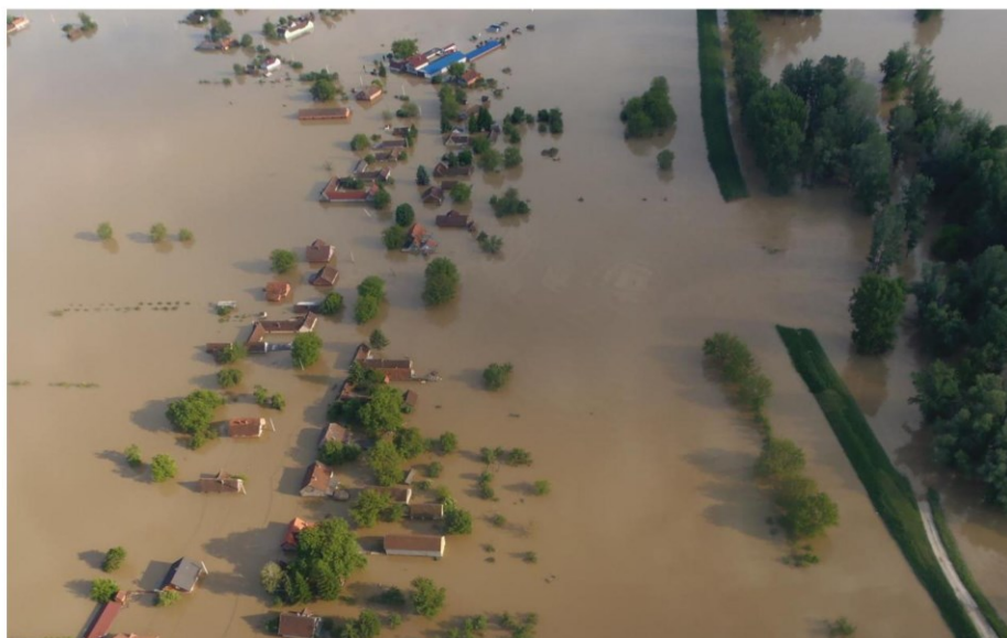
Slika 19 Lokacija proboja savskog nasipa kod Rajevog Sela u Županjskoj posavini, 17. svibanj 2014. godine
