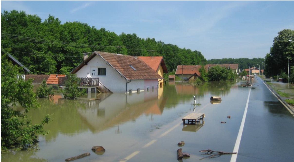
Abbildung 21: Überschwemmung im Teil der Region Posavina um die Stadt Županja am 17. Mai 2014
