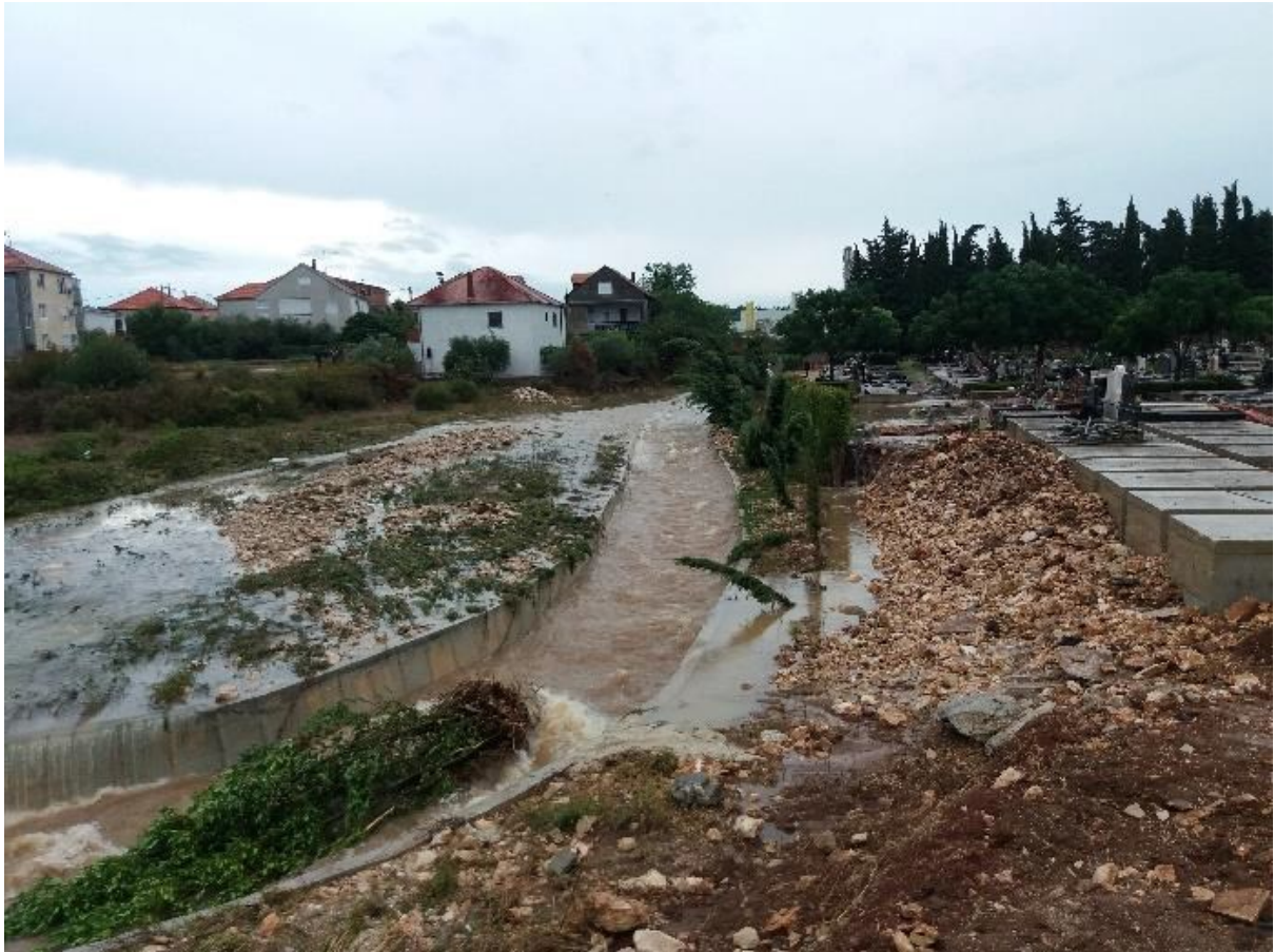
Abbildung 25: Zerstörter Teil des Friedhofes entlang des Stromes Ričina in Zadar am 11. September 2017
