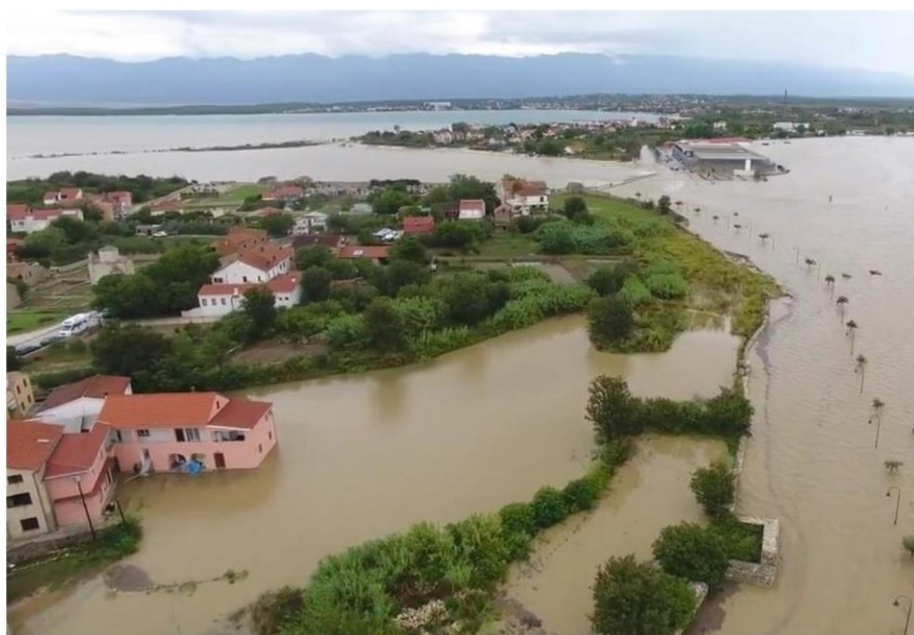
Slika 27 Poplavljene stambene objekte, solane i poslovne objekte u Ninu, 11. rujna 2017. godine
