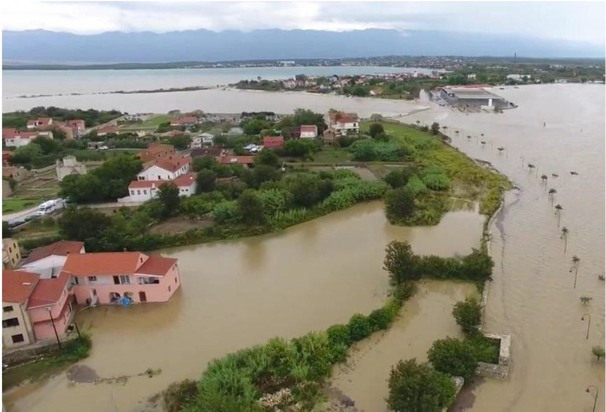
Abbildung 27: Überflutete Wohn- und Geschäftsobjekte und das Salzwerk mit der Saline in Nin am 11. September 2017
