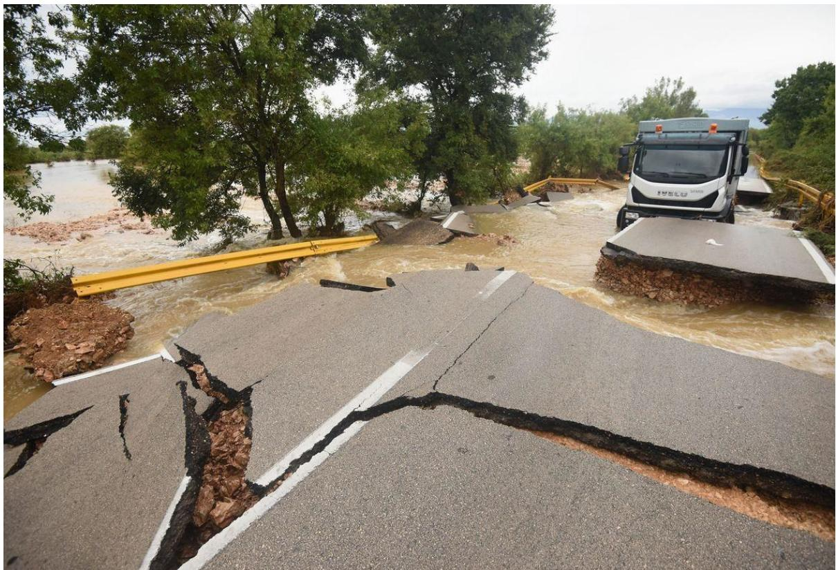
Abbildung 28: Beschädigung der Straße zwischen Zadar und Ražanac am 11. September 2017
