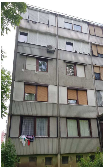
Slika 25: Zazidana prozorska membrana
