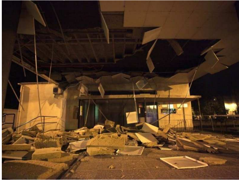
Slika 30: Urušavanje stropa, Dom zdravlja Remetinec
