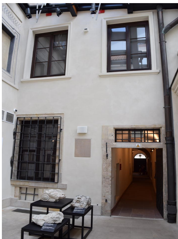
Slika 110: Stražnje pročelje kamienice Pod
