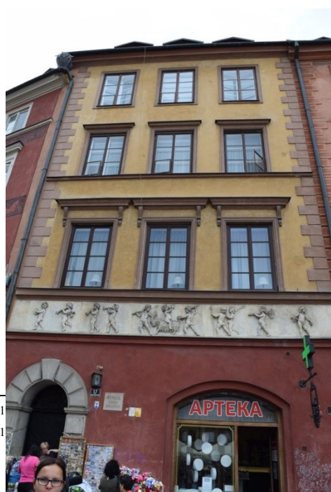
Slika 36: Kamienica Godswillerovih, foto: Maja Bituh
