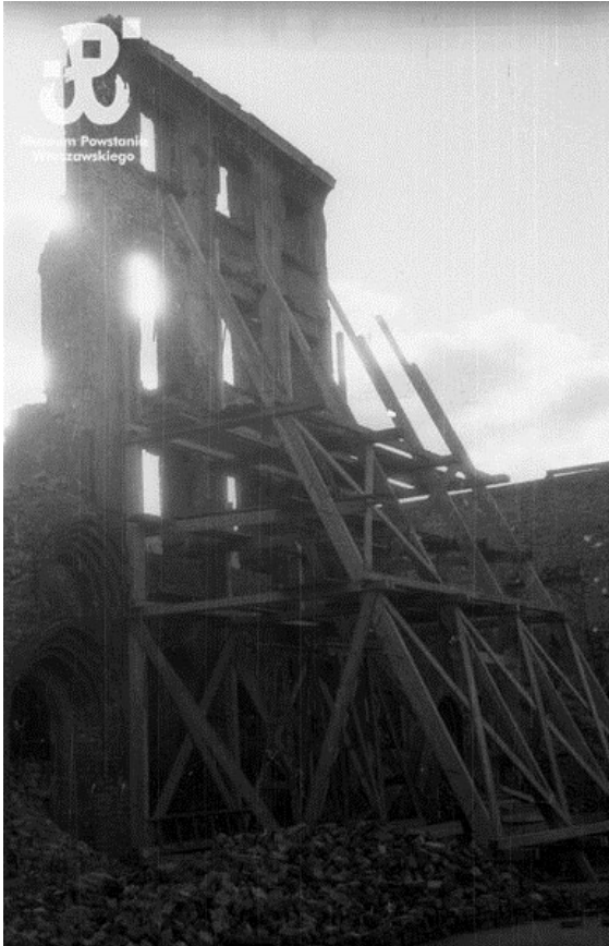
Slika 47: Konsolidacija pročelja kamienice 21a, foto: Karol Pęcherski
