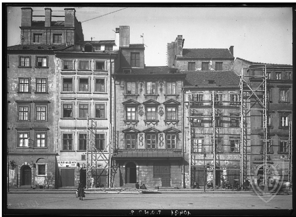
Slika 61: Strana Kollātaja 1928. sa skelama podignutima za obnovu pročelja
