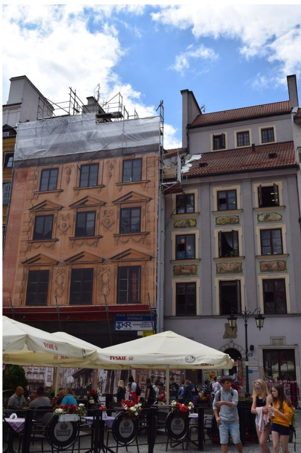
Slika 59: Kamienice Fukierowska i Gizińska; kamienica Fukierowska je pod skelom te se na njoj izvode konzervatorski radovi, foto: Maja Bituh
