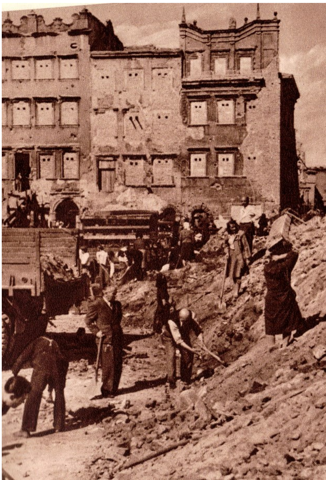
Slika 96: Čišćenje ruševina 1948., u pozadini vidljiva oštećenja kamienice Falkiewiczowske
