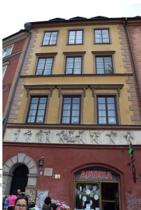
Slika 36: Kamienica Godswillerovih, foto: Maja Bituh
