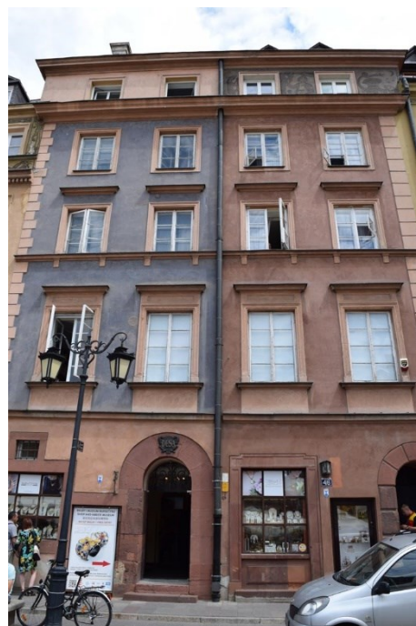
Slika 71: Kamienice Czempieńska i Gizińska, foto: Maja Bituh
