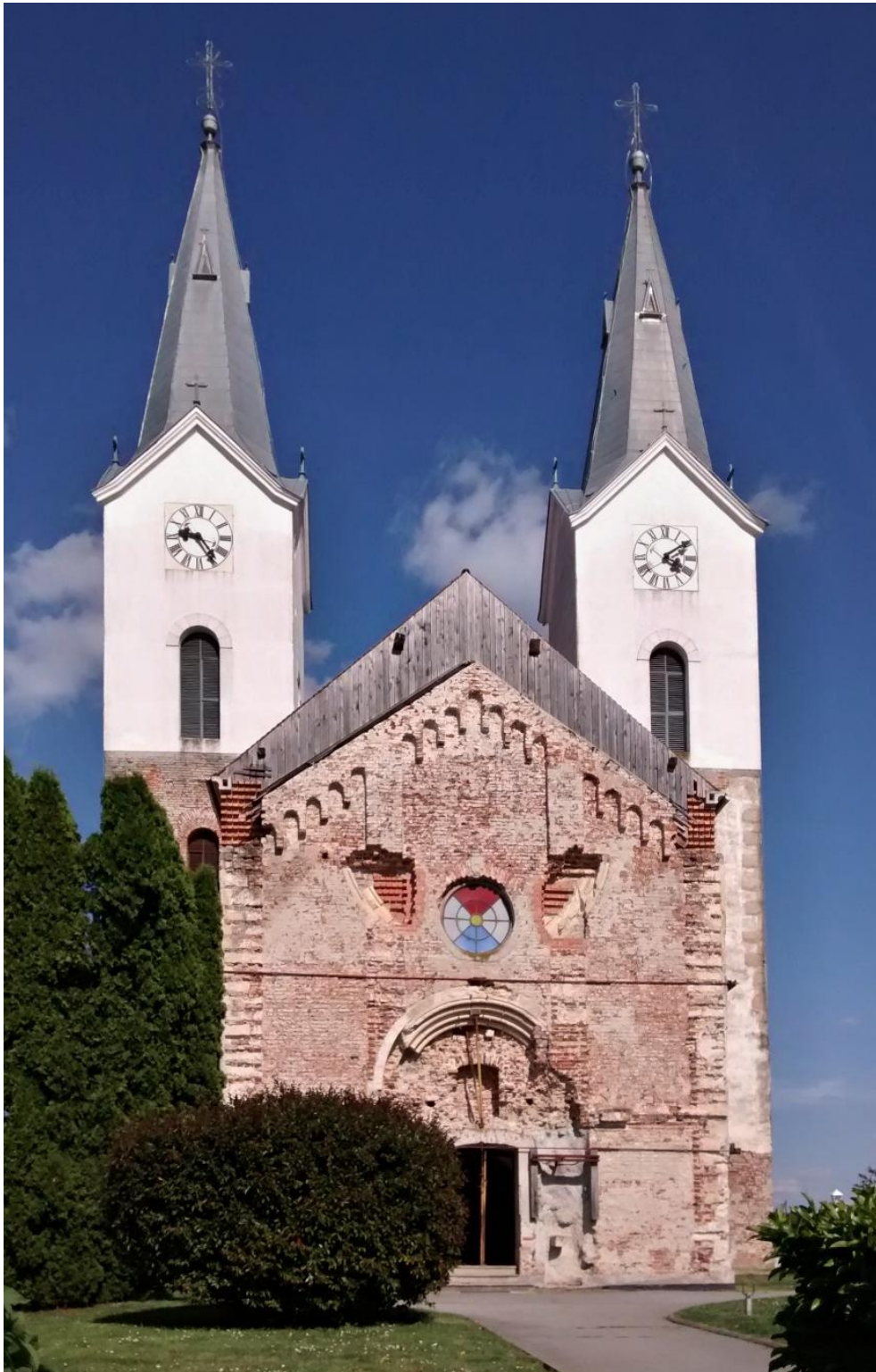
Slika 9. Zapadno pročelje crkve Sv. Marije Magdalene u Čazmi prije restauratorskih radova
