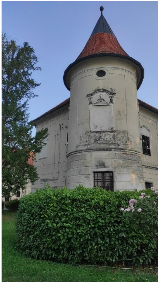
Slika 30 – Zazidani prozorski otvor na prvom katu, sjeverozapadna ugaona kula, dvorac Lužnica
