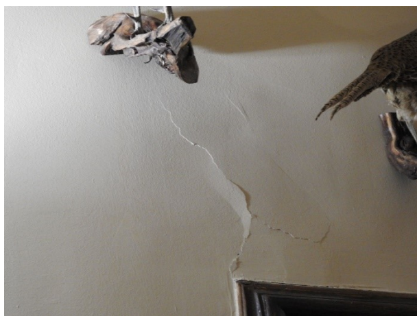
Slika 63 – Pukotine na zidnim površinama u interijeru nastale nakon potresa 28. i 29. prosinca 2020. godine, dvorac Lužnica
