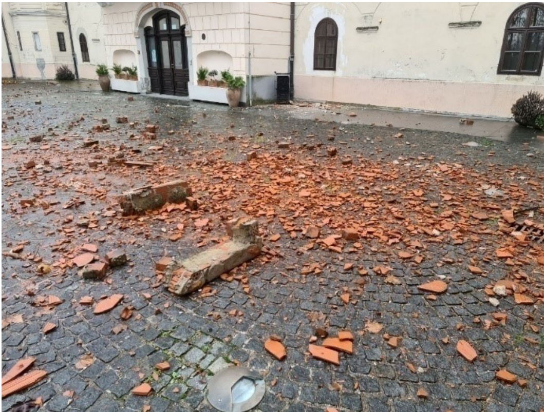
Slika 60 – Crijep koji je popadao nakon potresa 28. i 29. prosinca 2020. godine, dvorac Lužnica
