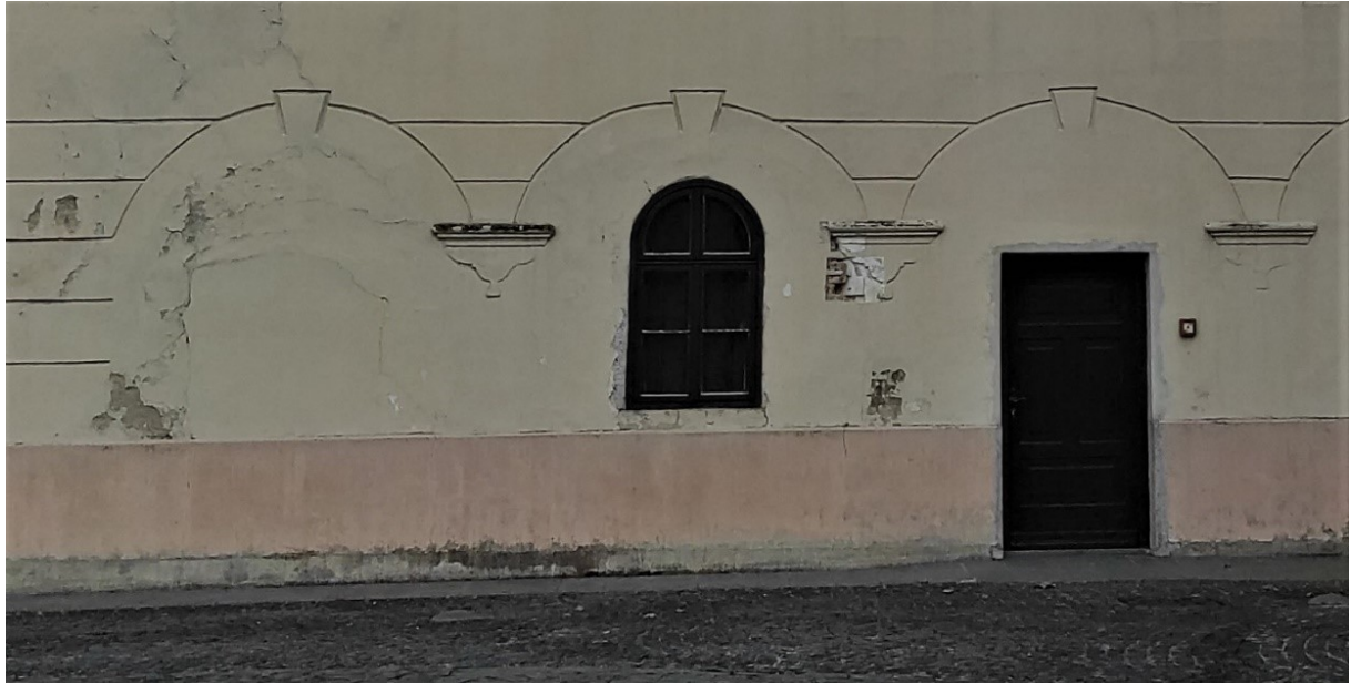
Slika 37 – Zazidani nekadašnji arkadno rastvoreni trijemovi, detalj obrisa segmentnih lukova, kapitela i dekoracije lambrekenima, sjeverno dvorišno pročelje, dvorac Lužnica
