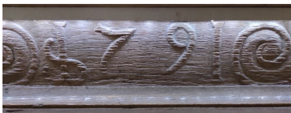
Slika 52 – Detalj urezane 1791. godine, ulazno stubište, dvorac Lužnica
