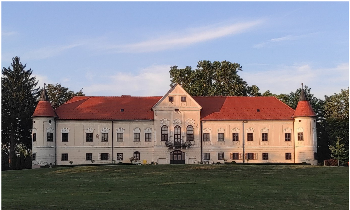
Slika 45 – Južno pročelje, dvorac Lužnica
