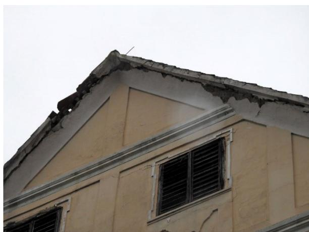
**Slika 62 – Oštećeni potkrovni dijelovi žbukanih površina pročelja nakon potresa 28. i 29. prosinca 2020. godine, dvorac Lužnica**
