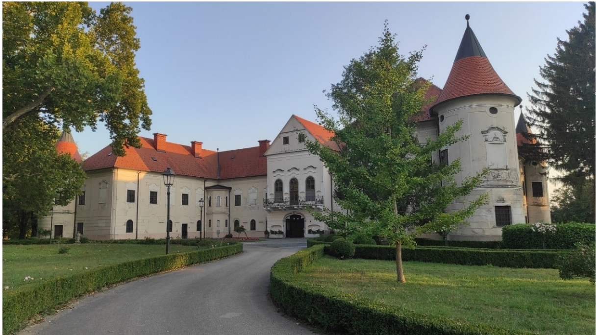
Slika 35 – Sjeverno dvorišno pročelje, dvorac Lužnica
