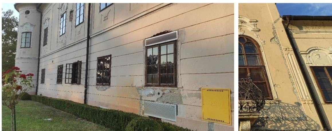
**Slika 65 – Oštećenja uzrokovana ugradnjom ventilacije i prolaskom instalacija, južno pročelje, dvorac Lužnica**
