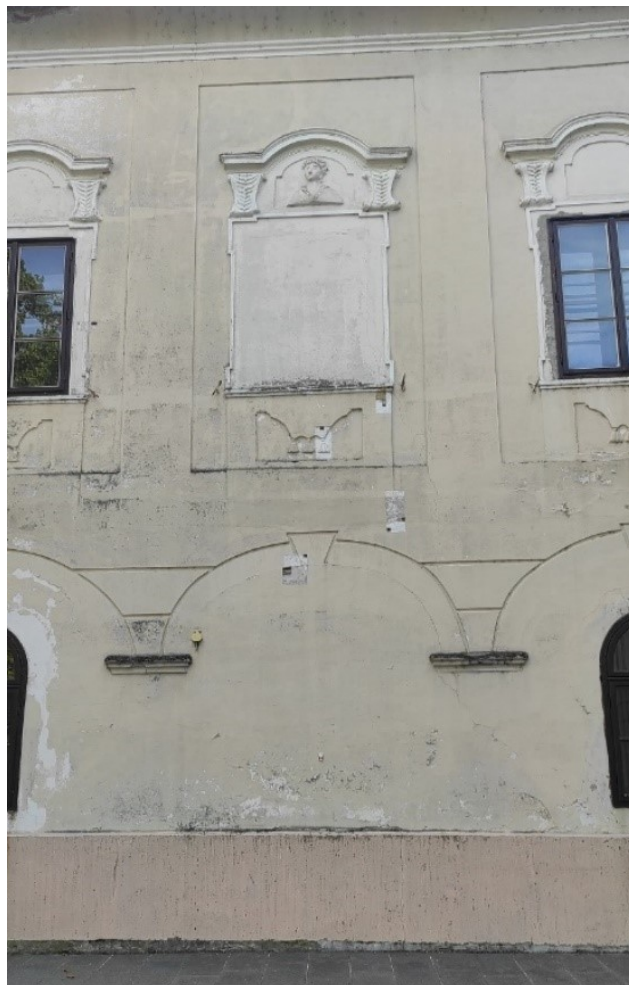
Slika 38 – Detalj oblikovanja pročelja, sjeverno dvorišno pročelje, dvorac Lužnica
