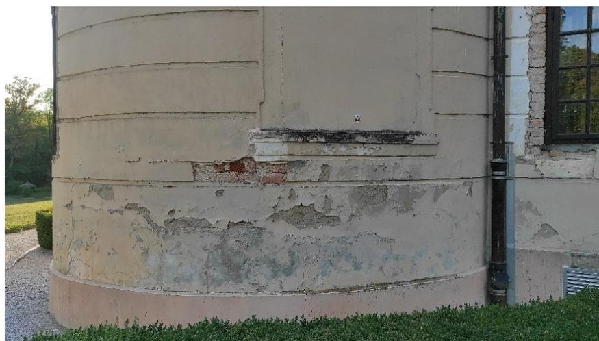
**Slika 64 – Oštećenja uzrokovana kapilarnom vlagom, jugoistočna ugaona kula, dvorac Lužnica**
