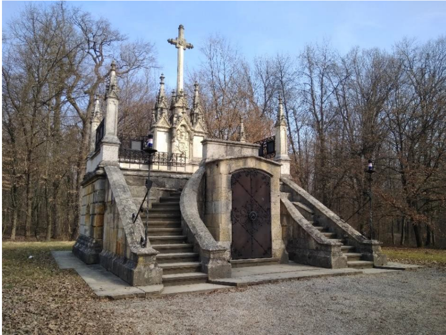
Slika 8 – Grobnica obitelji Jelačić, Novi dvori, Zaprešić, izvedena 1884. po projektu H. Bolléa
