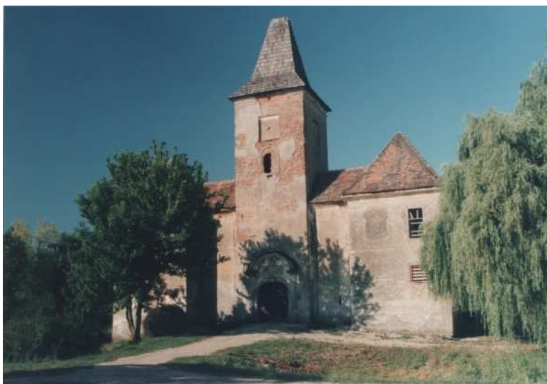
Slika 7. Pročelje prije restauracije
