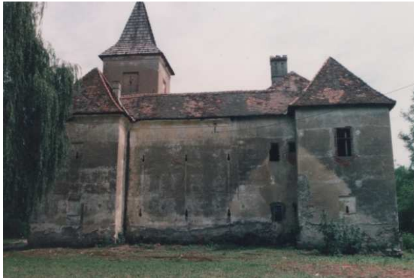
Slika 9. Bočna strana prije restauracije
