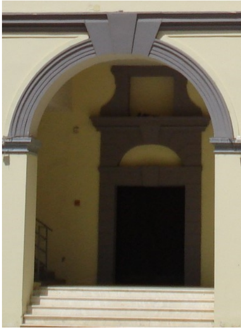
Slika 12a: Portal sjeverozapadnog krila
