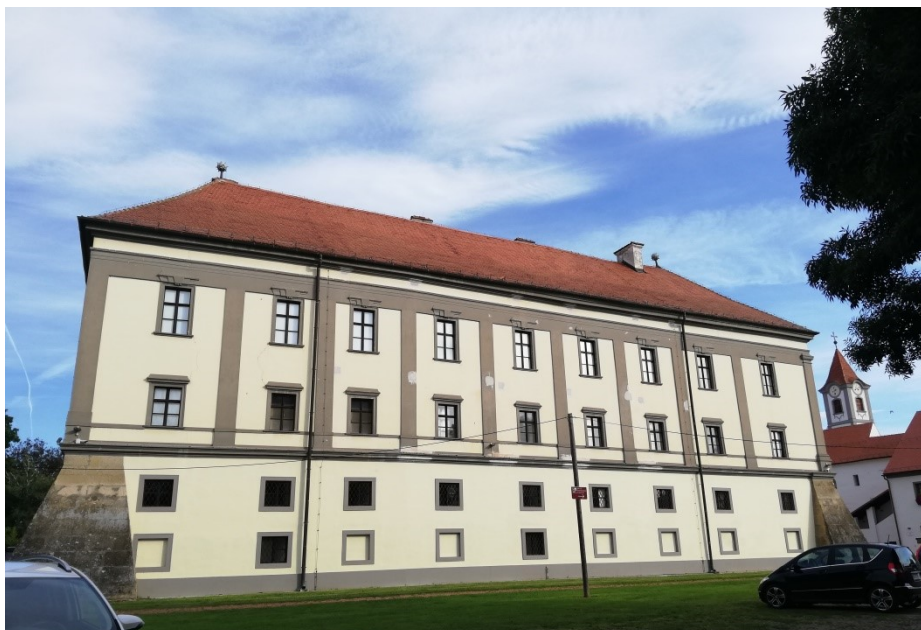
Slika 10: Jugoistočno pročelje, pogled s juga
