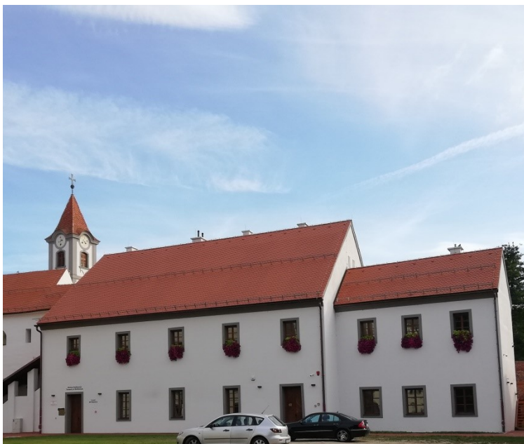
Slika 18: Faksimil barokne zgrade, pogled s istoka
