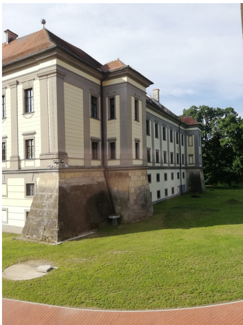
Slika 6: Kontrafor sjeveroistočnog i sjeverozapadnog krila te kutni rizaliti sjeverozapadnog krila, pogled sa sjevera
