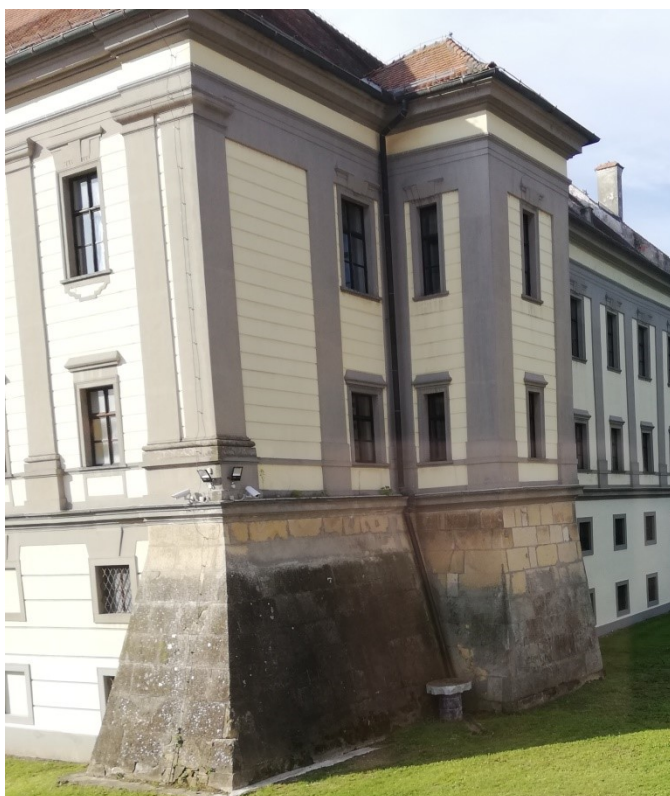
Slika 11: Sjeverni rizalit sjeverozapadnog pročelja
