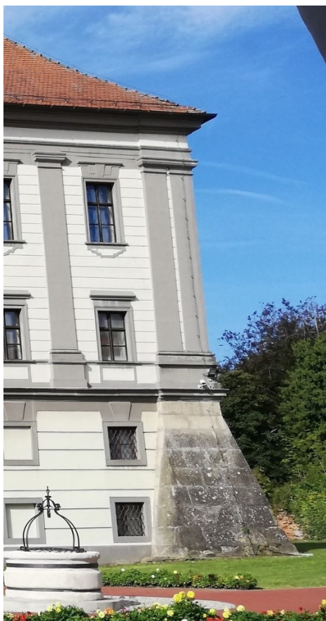
Slika 8a: Dvostruki pilastri iznad kontrafora
