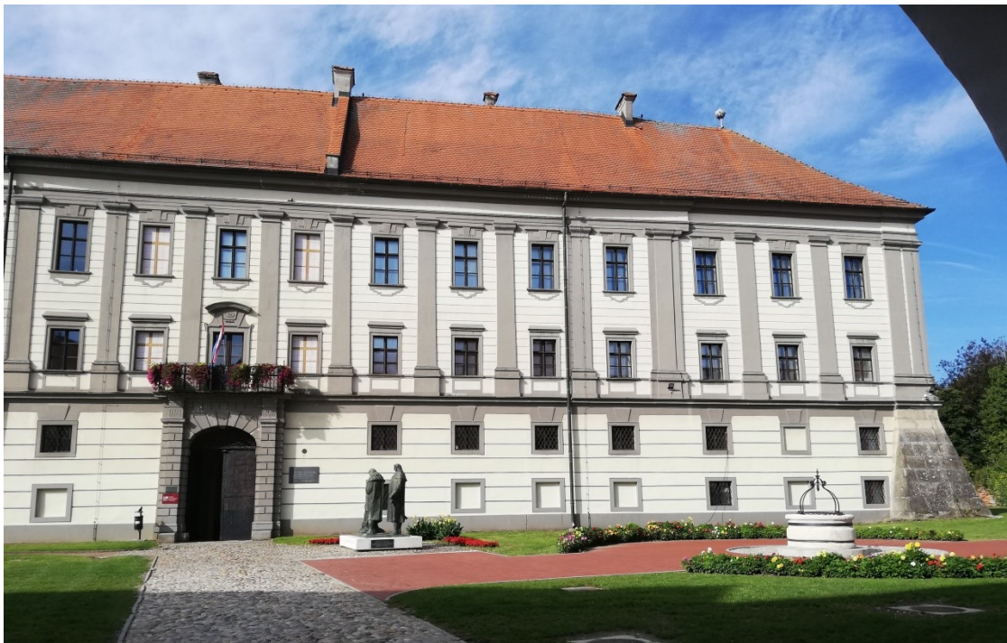
Slika 8: Glavno pročelje, pogled sa sjeveroistoka
