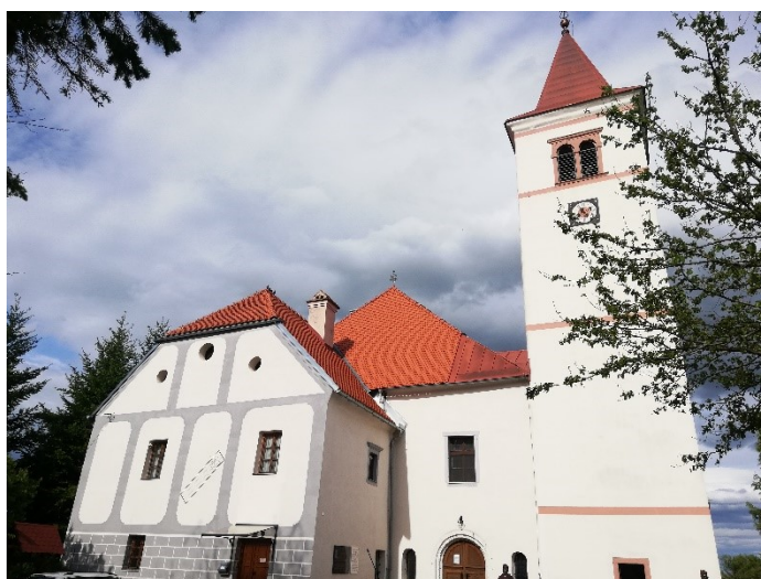
Slika 2. Pogled sa zapada na glavno pročelje samostanskog kompleksa i crkve u Svetičama
