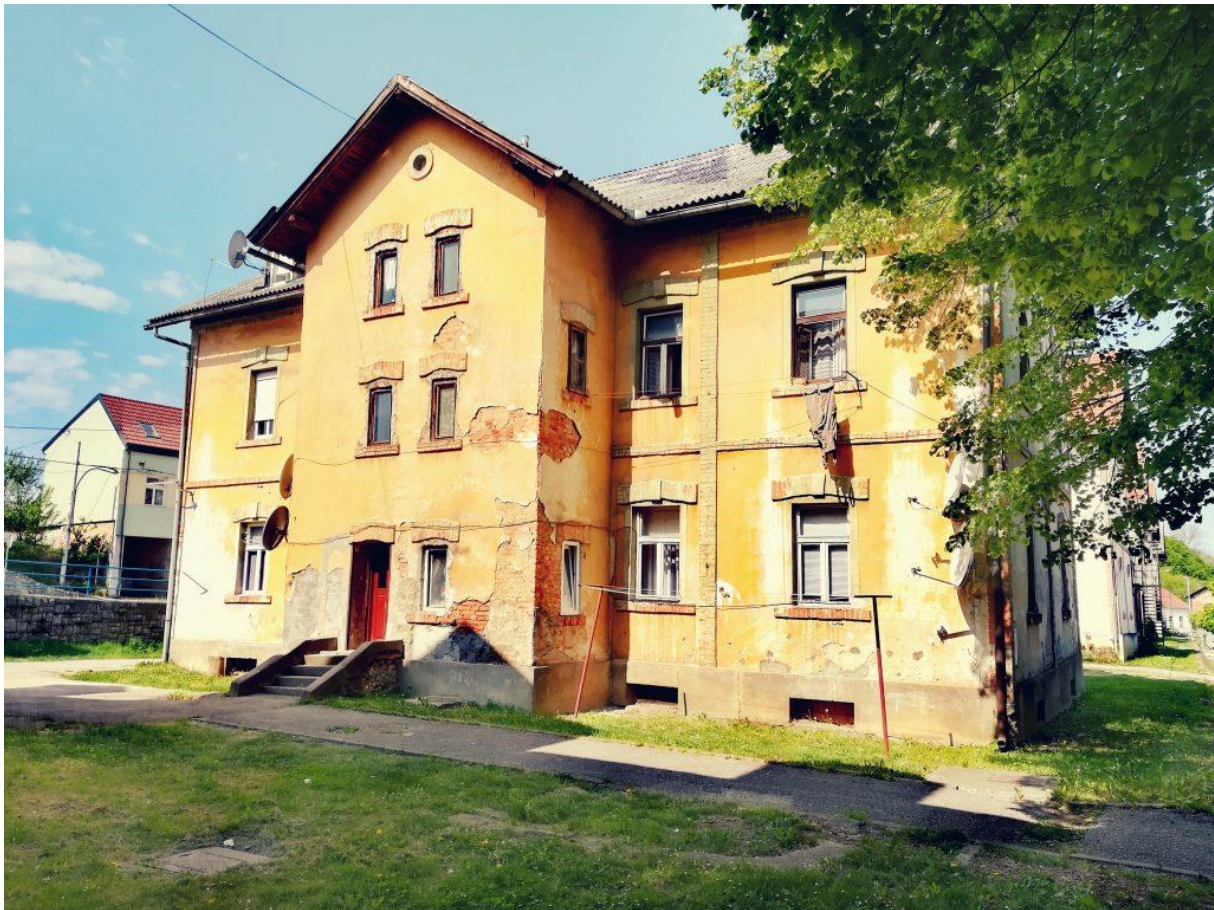
Sl. 5. Današnji izgled tipične radničke zgrade u Dugoj Resi
