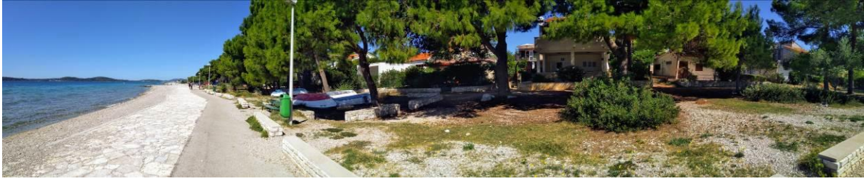
Prilog 38. Panoramska fotografija objekata uz obalu na središnjem dijelu Jadrije. Uz prizemnice se pojavljuju apartmani s prizemljem i jednim katom. Fotografirala Martina Šoda u rujnu 2019.
