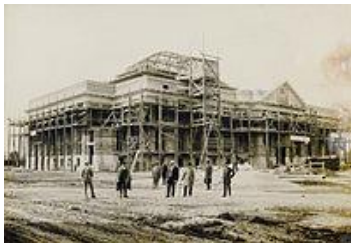
Slika 5. Zgrada Knjižnice na Marulićevom trgu u izgradnji
