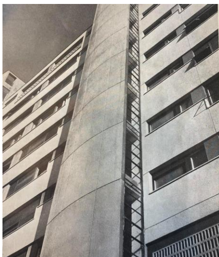
31. Detalj pročelja stambene zgrade u Beogradskoj ulici u Zagrebu, (izvor: časopis Arhitektura 1-6 (1956.), str. 11.)
