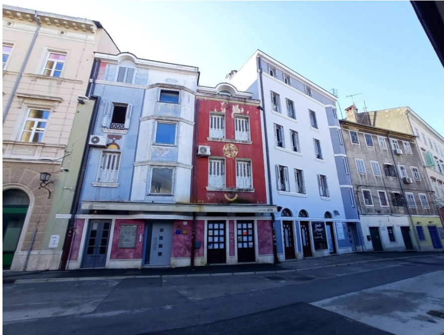
Slika 51. Pročelje zgrade na lokaciji br. 2
