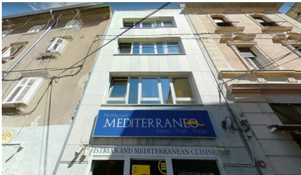
Slika 44. Pročelje poslovnog dijela zgrade
