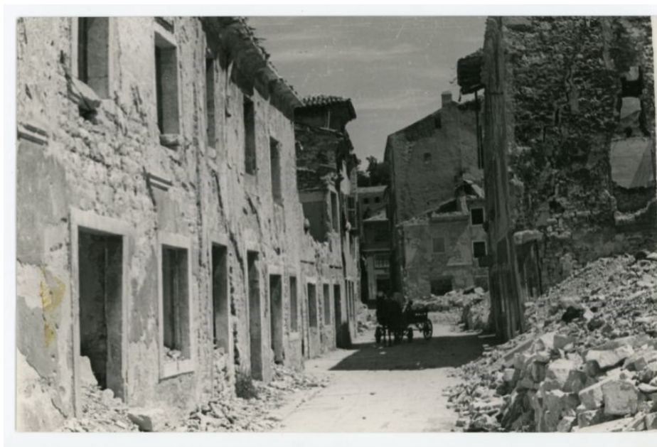
Slika 17. Blok zgrada na mjestu današnjeg Parka grada Graza
