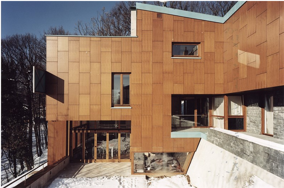
Slika 62. Južno dvorišno pročelje Vile Klare
