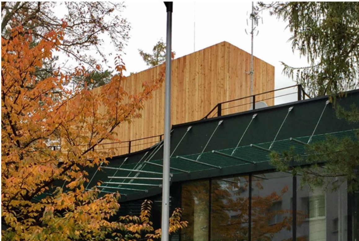
Slika 106. Fotografija jednog apartmana na krovu Zelenog paviljona
