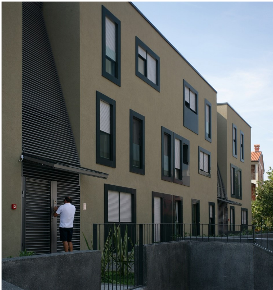
Slika 40. Ulazna strana višestambene građevine Sveti Vid u Rovinju
