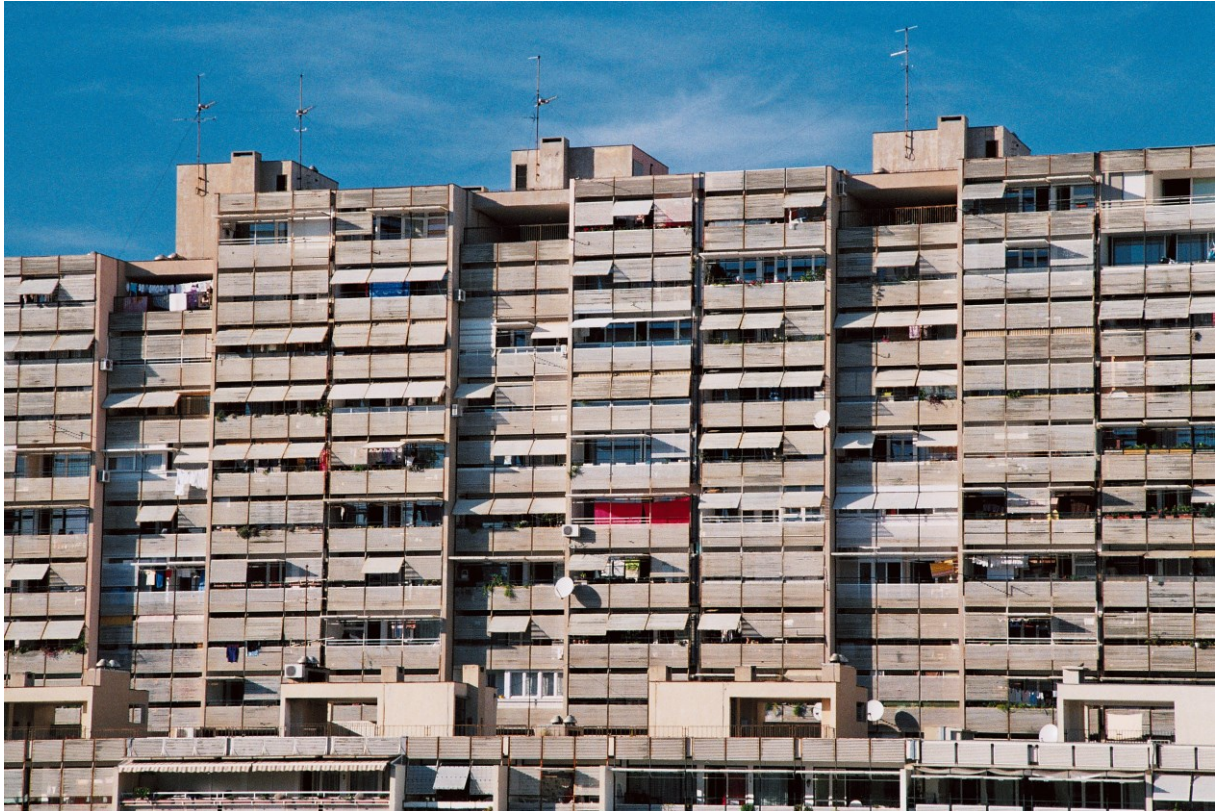
Slika 144. Pročelje stambene zgrade u Papandopulovoj ulici u Splitu arhitekta Ive Radića
