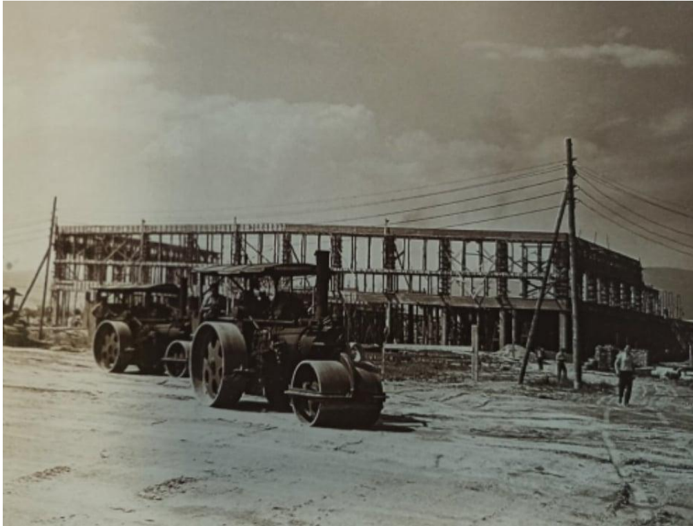
SLIKA 14. IZGRADNJA ZAGREBAČKOG VELESAJMA 1955. GODINE ( Povijest grada Zagreba, 180. )
