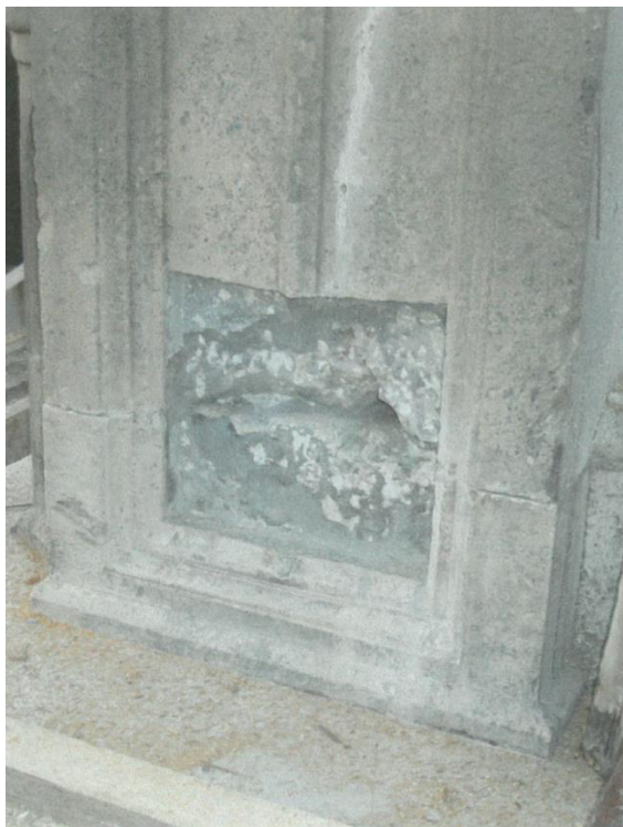
Slika 30. Demontaža tašela na zapadnoj strani
