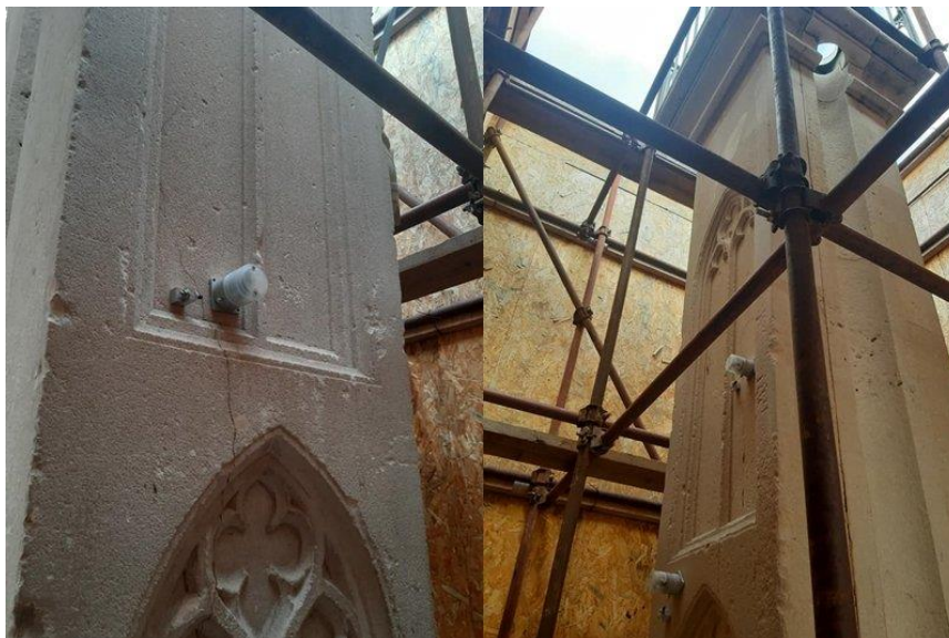
Slika 57. Senzori za statički monitoring
