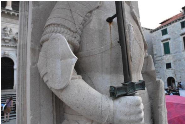
Slika 43. Detalj- pukotina preko oklopa i desnog ramena
