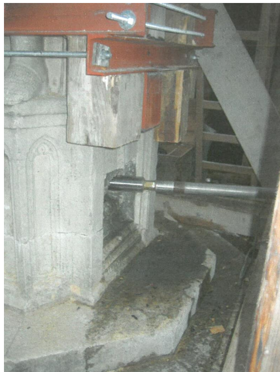
Slika 31. Presijecanje metalnog trna
