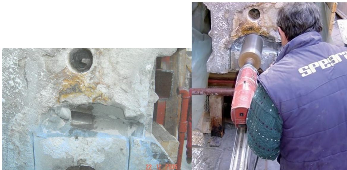
Slike 32, 33. Odvojeno tijelo stupa s vidljivim presječenim trnovima; Bušenje centralne bušotine
