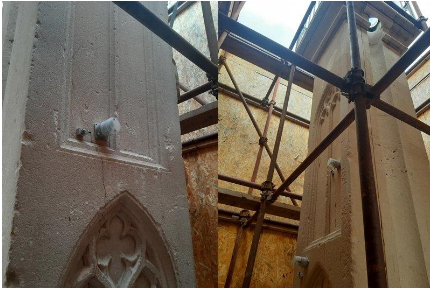
Slika 57. Senzori za statički monitoring
