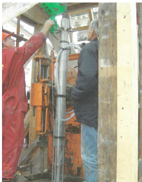
Slika 37. Ugradnja središnje zatege
