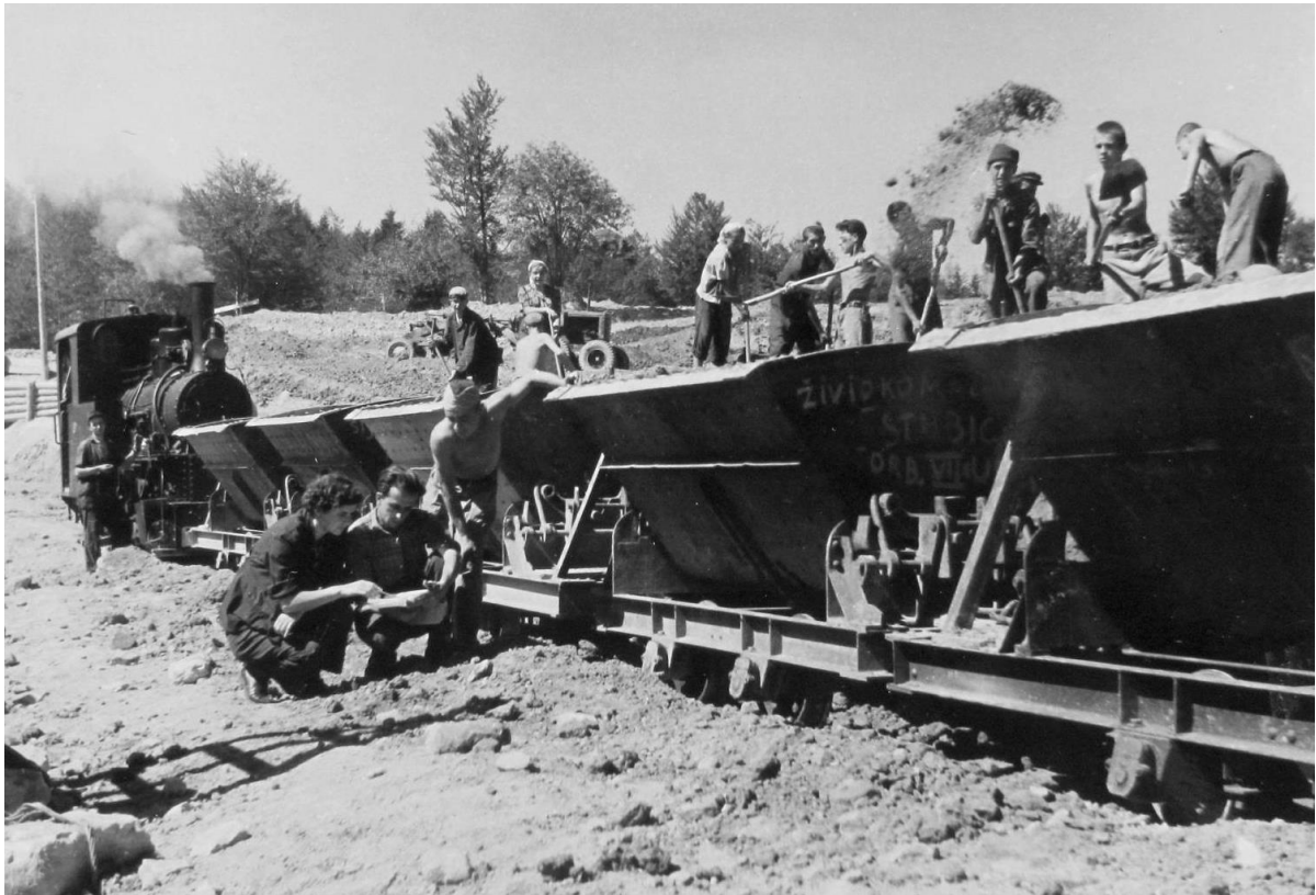
Slika 48. i slika 49. Rad na gradnji brane (privatni arhiv)
