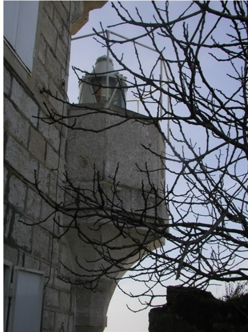
Slika 33 Svjetionik Rt Zub – detalj ugaonog istaka za smještaj lanterne
