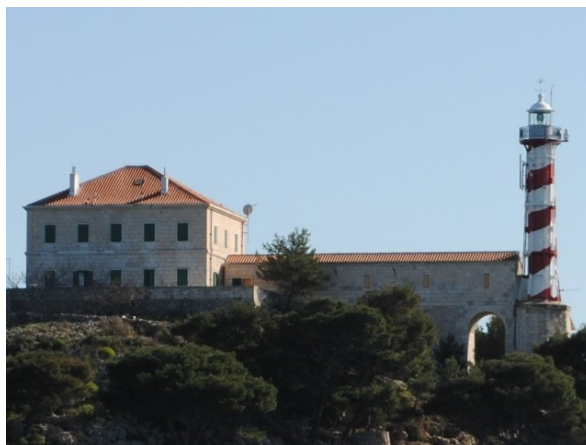
Slika 83 Svjetionik Sestrica Vela na sjeverozapadnoj strani Nacionalnog parka Kornati
