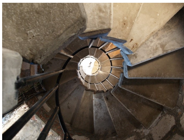
Slika 59 Stepenište kule na svjetioniku Mulo
