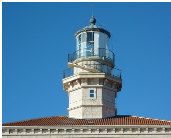
Slika 103 Detalj pokrovnog vijenca i kule s lanternom na svjetioniku Glavat
