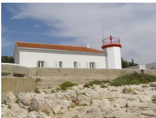
Slika 85 Svjetionik na rtu Verudica
