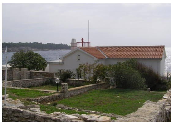
Slika 86 Stražnja strana svjetionika na rtu Verudica
