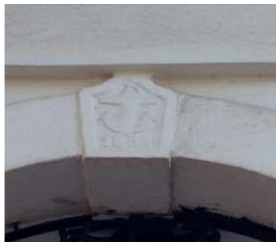
Slika 49. Zaglavni kamen s ulaznih vrata, Vladimira Gortana 7
