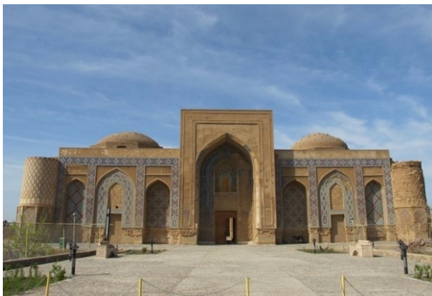
Slika 42: prednje pročelje medrese al-Ġiyāšīyya (izvor: gardeshgari724.com )
