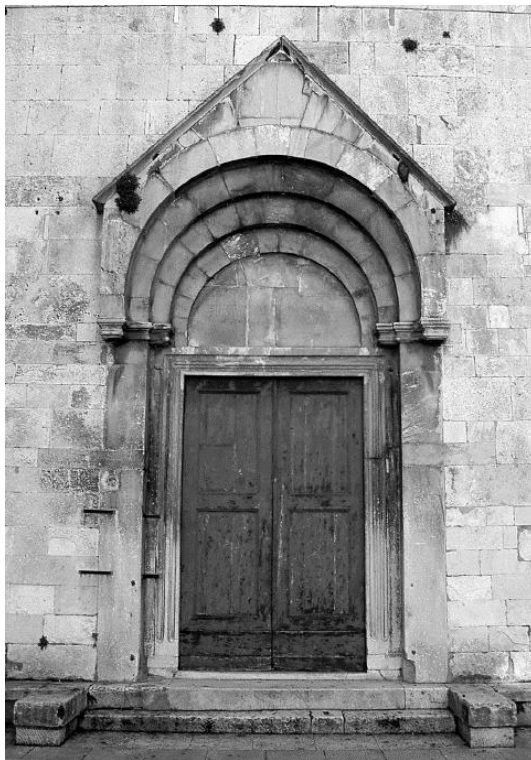
Sl. 4. Crkva Sv. Krševana, zapadno pročelje, glavni portal (foto: E. Hilje)
